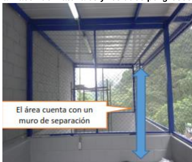
Fotografía 3.3.2-1. Interior del del área y/o almacén de materiales y residuos peligrosos
