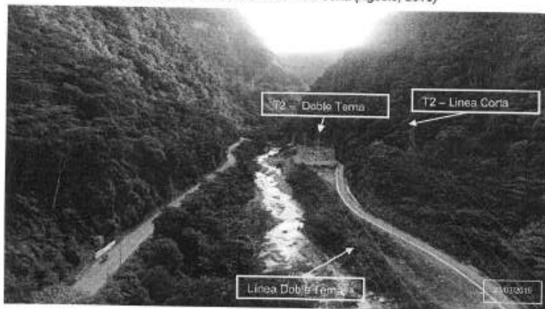
Fotografía 13: Torre 02 de la Línea Corta (Agosto, 2019)
