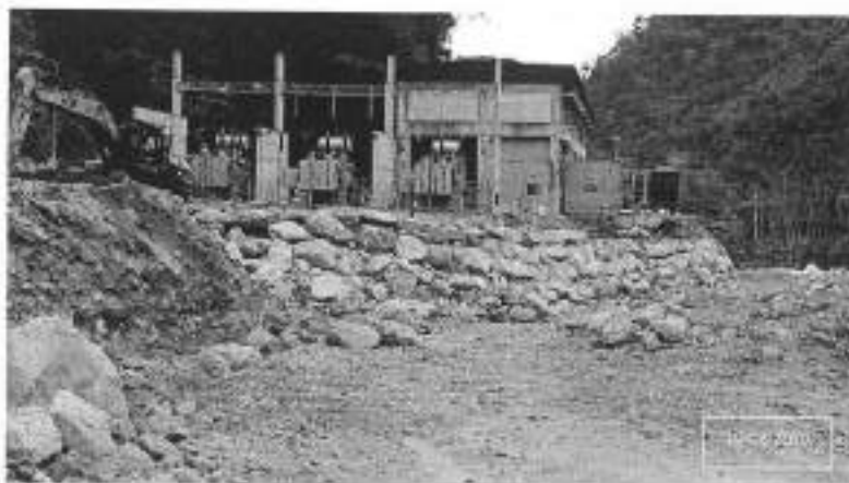
Fotografía 10: Trabajos finales enrocado Casa Máquinas (Agosto, 2019)
