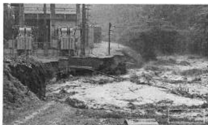
Fotografía 06: Estado final de Casa de Máquinas después del evento extraordinario (Marzo, 2019)
