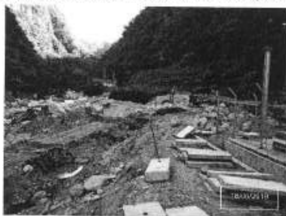
Fotografía 08: Avance de trabajos enrocado - Casa de Máquinas (Junio, 2019)
