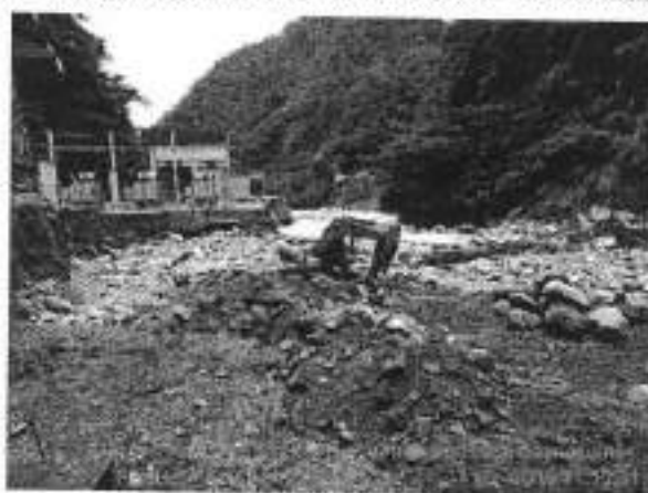
Fotografía 07: Inicio Trabajos de enrocado SE elevadora – Casa Máquinas (Abril, 2019)
