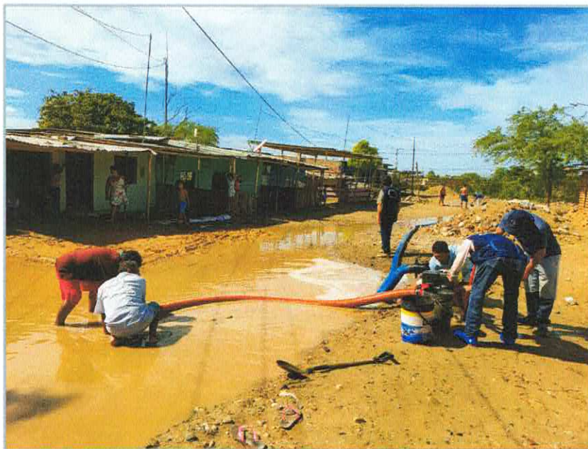
A.H. EL OBRERO: Cuadra 3. Ante formación de cuenca ciega se ha recurrido a la zona a realizar trabajos de evacuación de aguas pluviales, trabajos que han sido realizados con motobombas y personal trabajador de monitoreo de motobomba de esta subgerencia.
