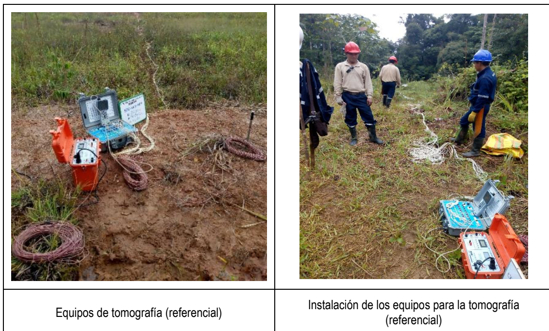
Fotografía 3-6 Instalación de los equipos de tomografía eléctrica
