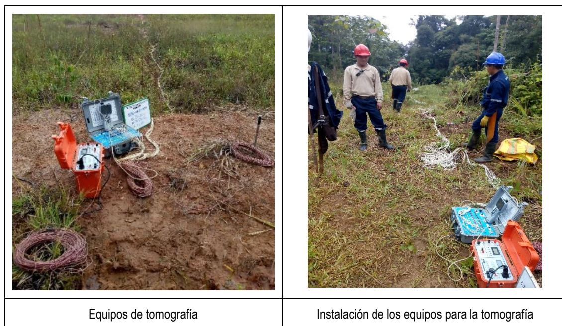
Fotografía 3-3 Instalación de los equipos de tomografía eléctrica
