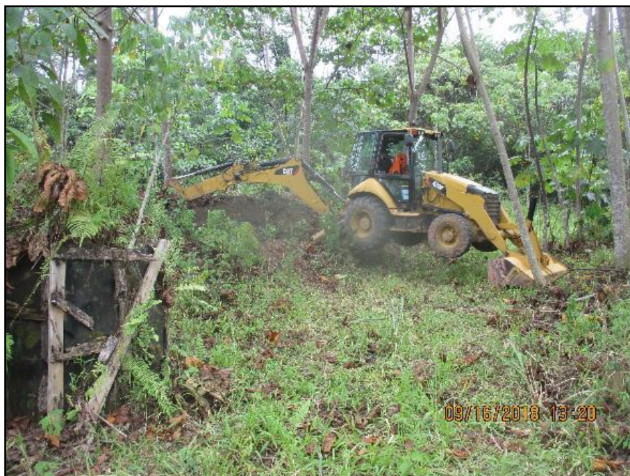
Fotografía 3-5. Excavación con Retroexcavadora
