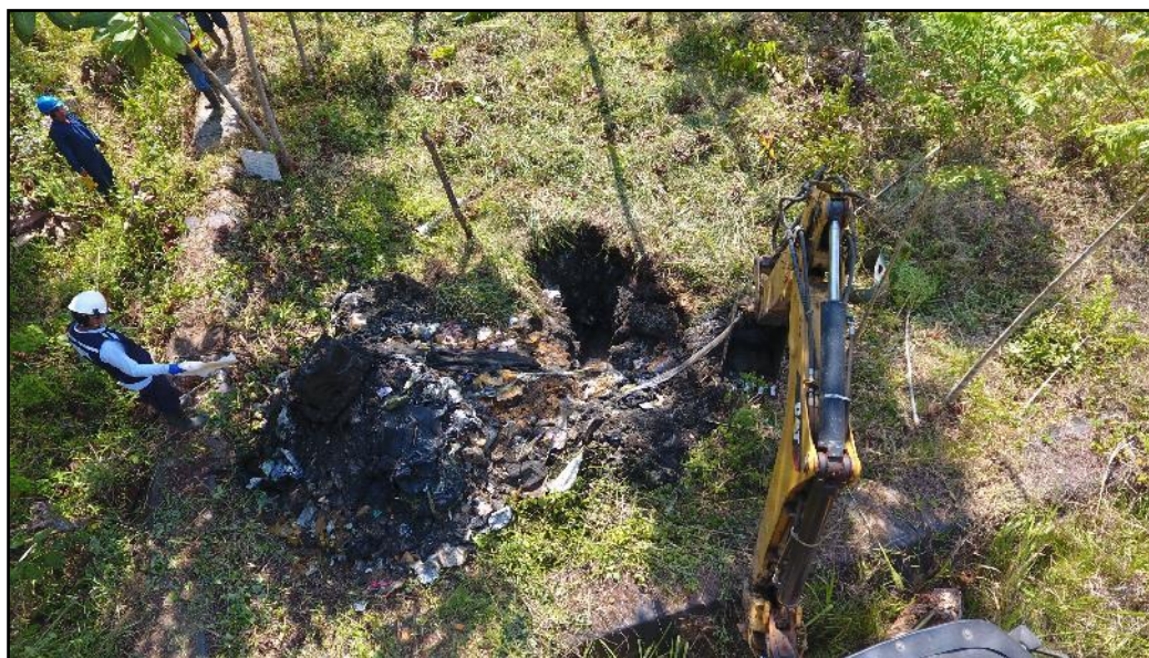
Fotografía 4-1. Excavaciones en celda de residuos por medio de máquina excavadora
