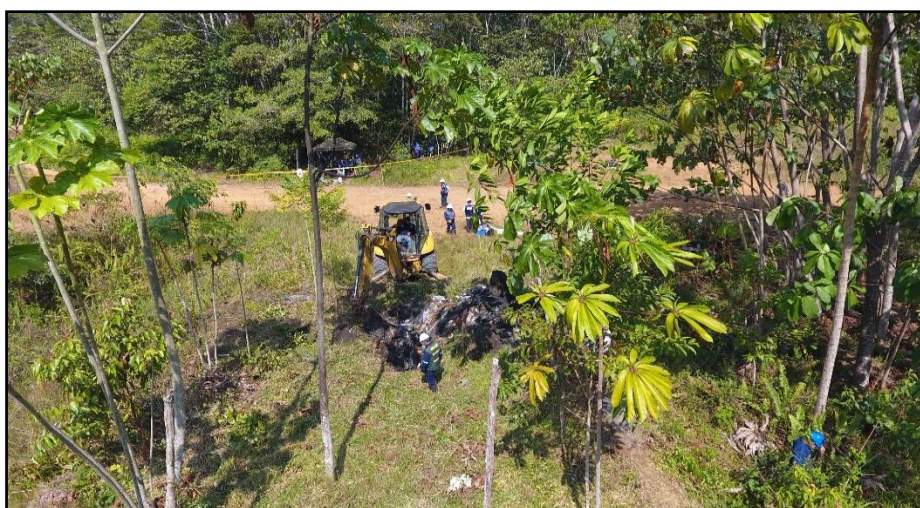
Fotografía 4-3. Focos de Suelo Excavaciones con máquina excavadora
