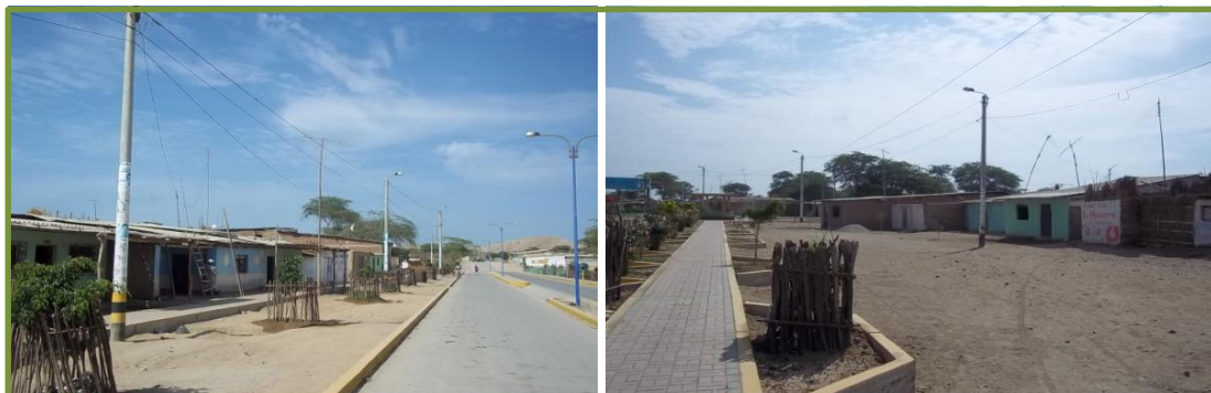
Foto N° 4.3 BA Alumbrado eléctrico en Viviendas del Ámbito de Estudio Social
