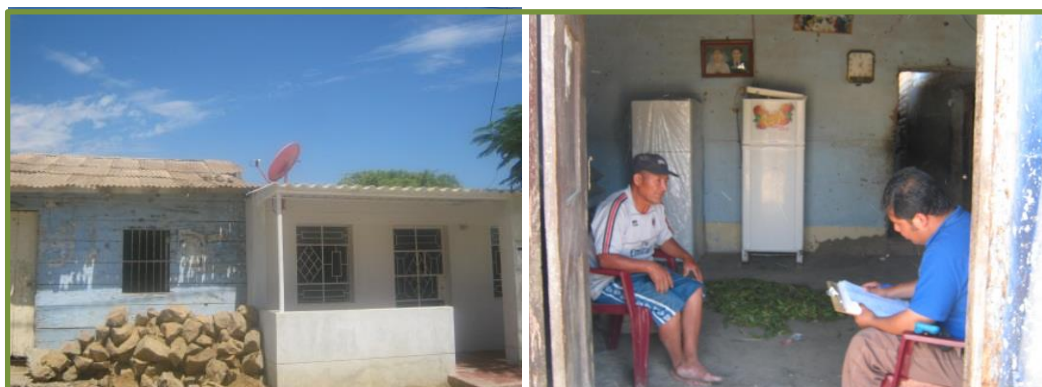
Foto N° 4.3 J SERVICIOS DE CONEXIÓN A TV POR CABLE – DISTRITO VICHAYAL
