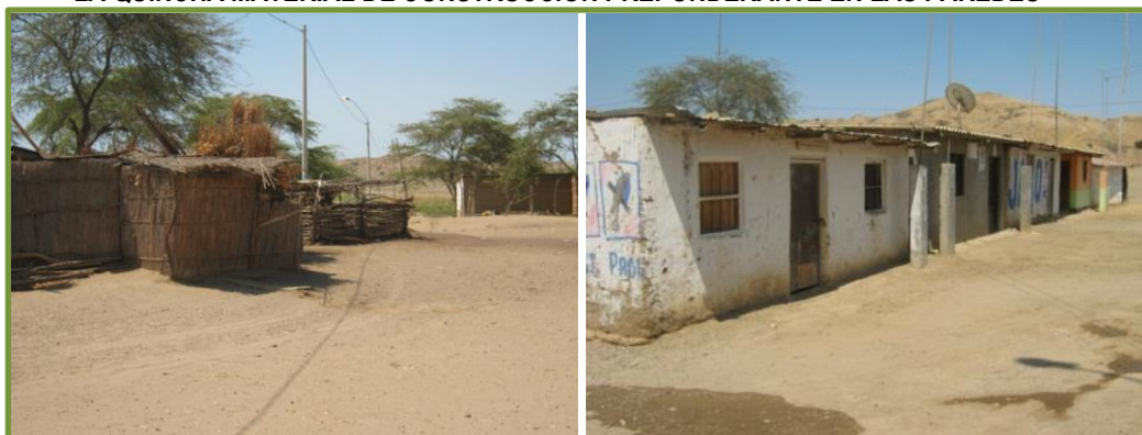
Foto N° 4.3 H LA QUINCHA MATERIAL DE CONSTRUCCIÓN PREPONDERANTE EN LAS PAREDES
