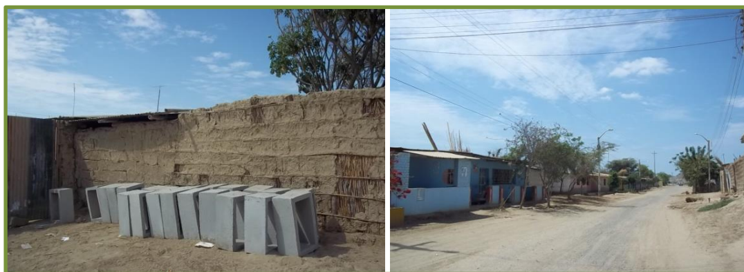
Foto N° 4.3 AA IMPLEMENTOS PARA LA RED DEL ALCANTARILLADO – DISTRITO TAMARINDO
