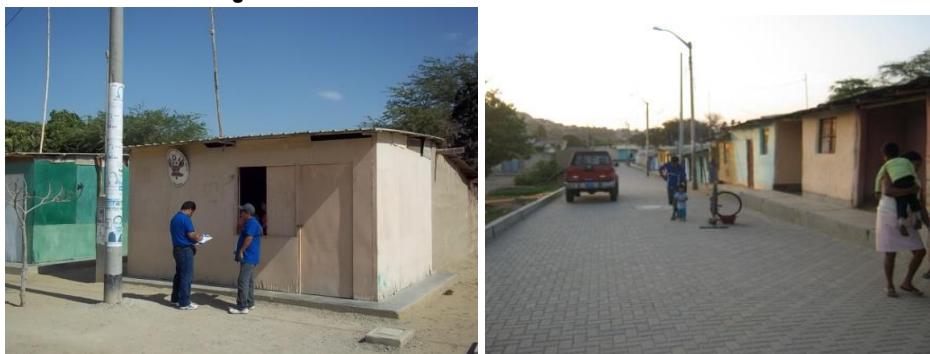
Foto N° 4.3 R Red de Agua dentro de la Vivienda – Nuevo San Francisco
