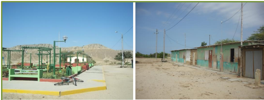
Foto N° 4.3 S ALUMBRADO ELECTRICO EN NUEVO SAN FRANCISCO – AMOTAPE
