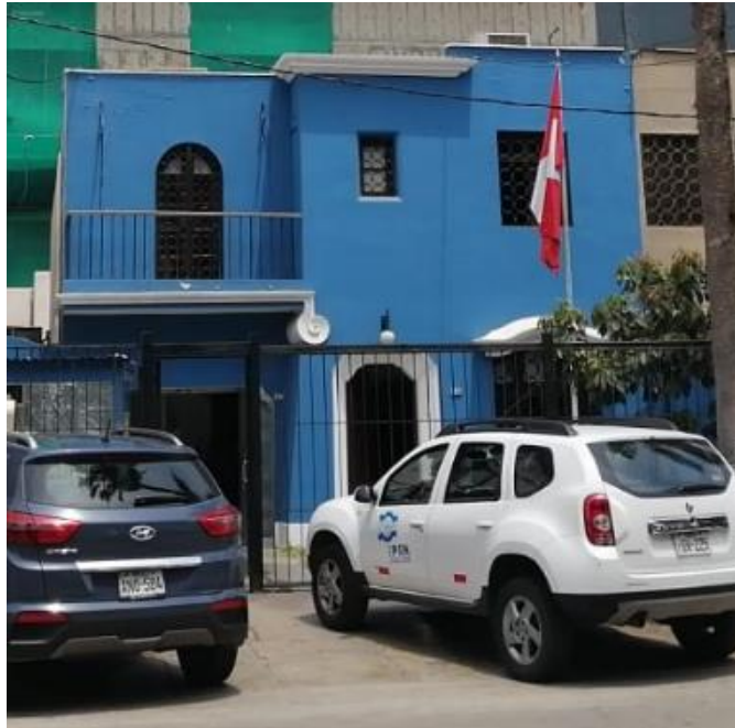
Figura N° 2. Sede Magdalena del Mar– Calle Faustino Sánchez Carrión 456
