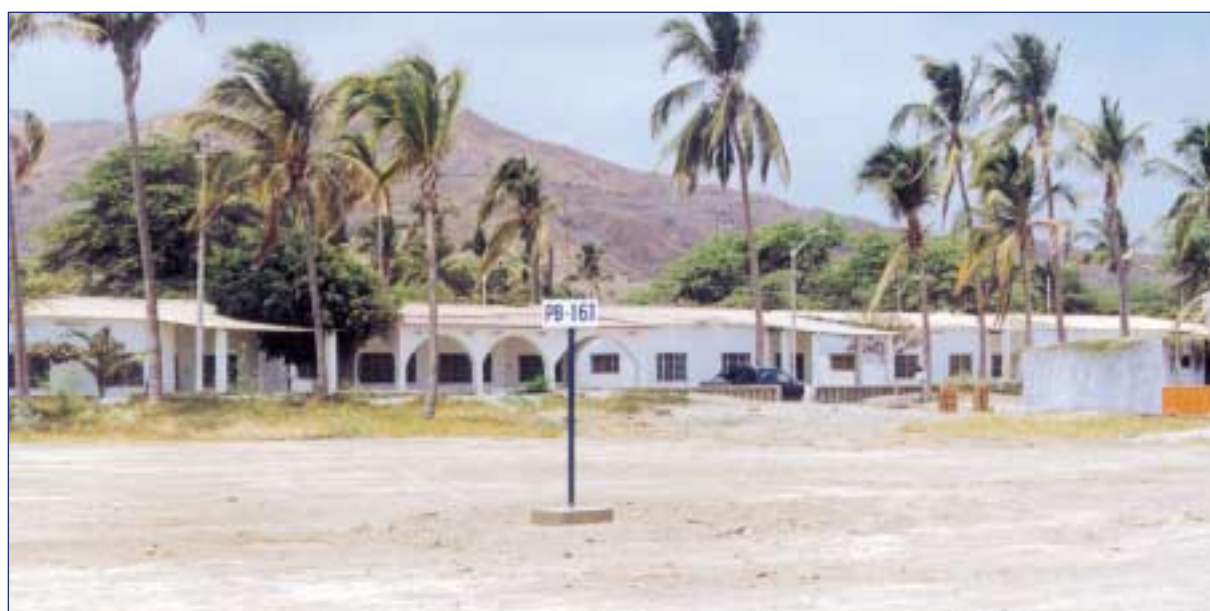
Vista que Muestra Facilidades Habitacionales con Pozo Abandonado - Noroeste
