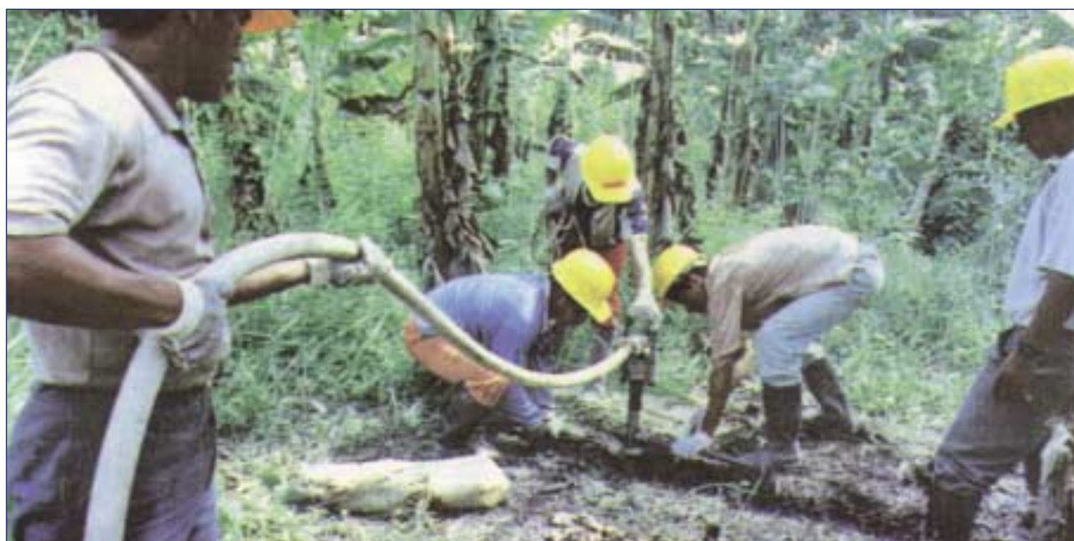
Colocando Explosivos en Línea Sísmica - Selva Norte
