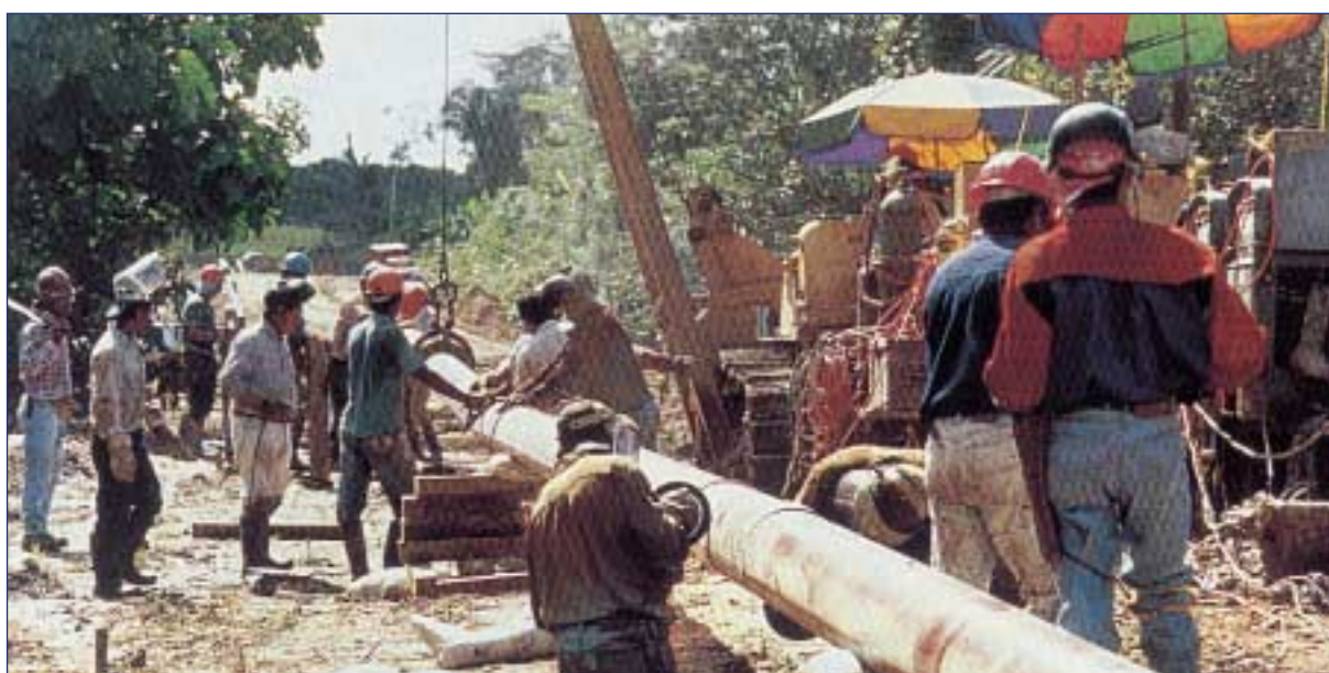
Construcción de Gasoducto - Selva Central Construction of Gas Pipeline – Central Jungle
