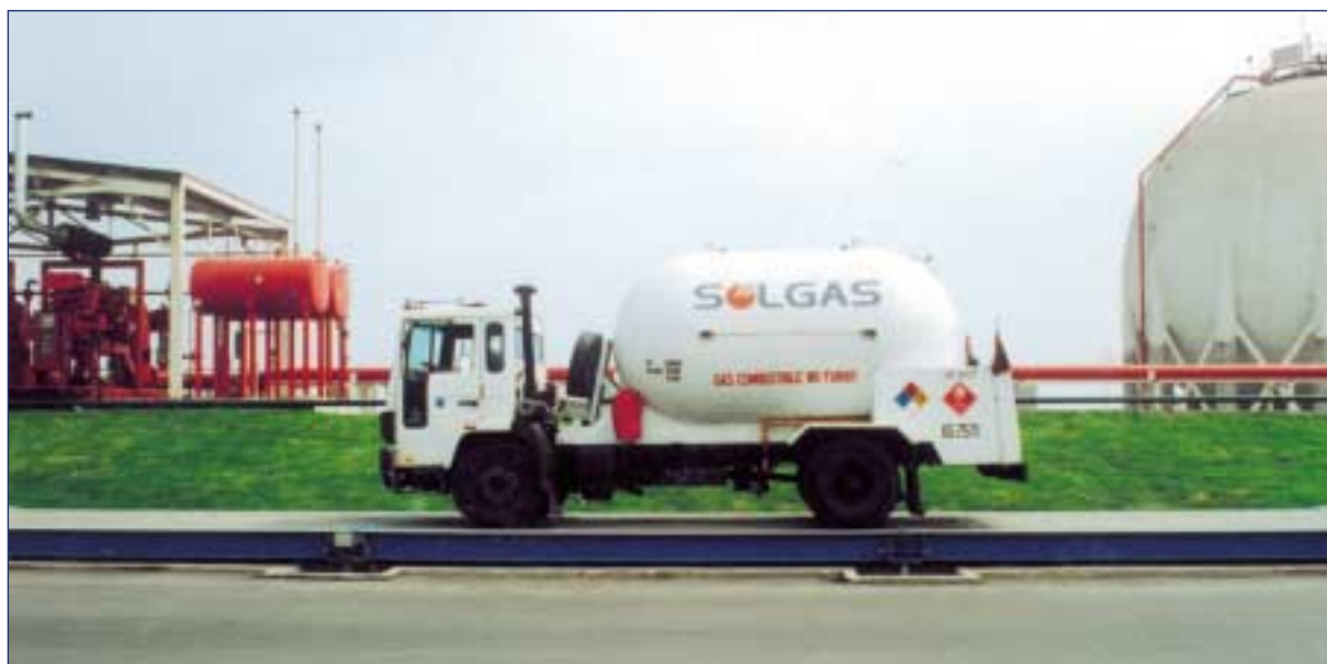
Planta de Abastecimiento de GLP. LPG Supply Plant.
