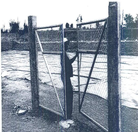
**Foto:** Se aprecia a la Presidenta de la Comisión Ordinaria de Infraestructura y Construcción del Consejo Regional La Libertad, inspeccionando la puerta del cerco perimétrico que es enmallada con F°G° 2", tal como indica el expediente técnico.
