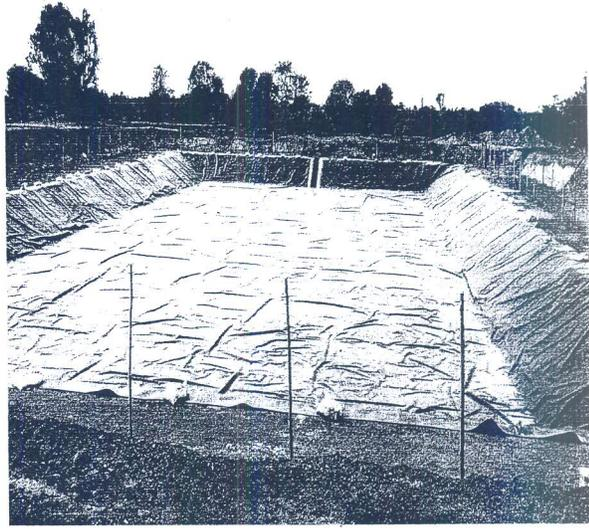
**Foto:** Vista general de la geo membrana en la laguna primaria, que viene siendo sostenida por sacos de arena y piedra a fin de que no se mueva.
