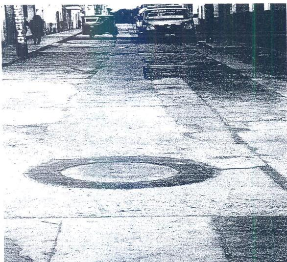
**Foto:** Se aprecia la existencia de un buzón cerrado; así mismo las calles se encuentran parchadas y en mal estado producto de la rotura del pavimento de concreto o asfalto, y de las veredas de concreto donde existe la tubería de agua y conexiones domiciliarias.
