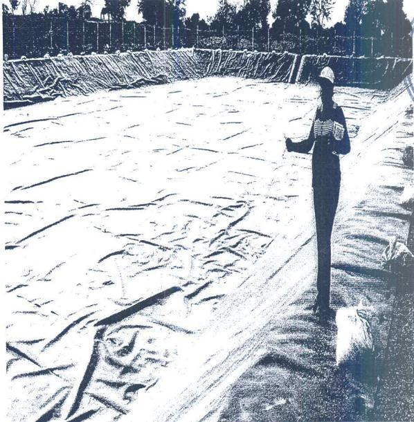
**Foto:** Se aprecia a la Presidenta de la Comisión Ordinaria de Infraestructura y Construcción del Consejo Regional La Libertad, señalando el pequeño charco de agua producto de las lluvias de la zona, indicando que la geo membrana aparentemente cumple con su función, que es evitar la contaminación del agua subterránea, ya que el agua no penetra sino se evapora por el calor del lugar.
