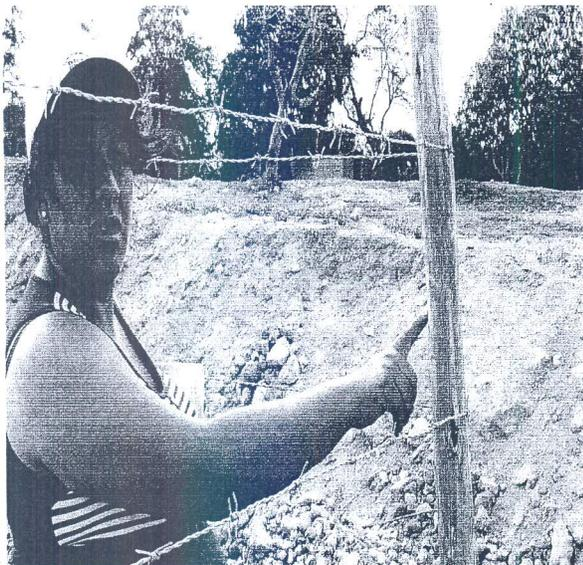
**Foto:** Se aprecia a la Presidenta de la Comisión Ordinaria de Infraestructura y Construcción del Consejo Regional La Libertad, inspeccionando el cerco perimétrico conformado por poste de madera con lambrado de púas N° 16 como indica el expediente técnico.
