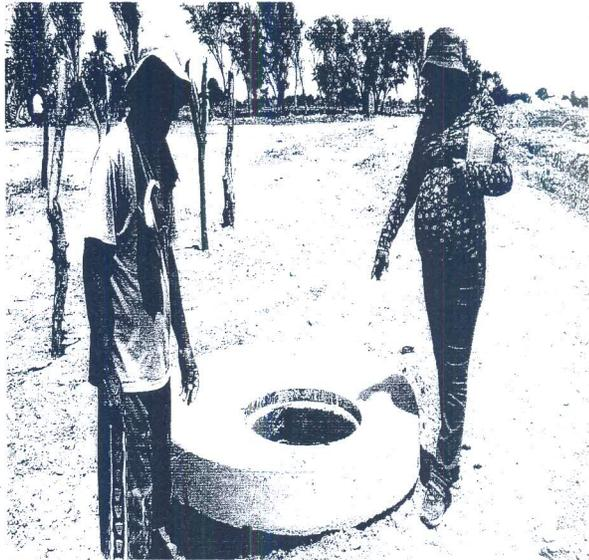
**Foto:** Se aprecia a la Presidenta de la Comisión Ordinaria de Infraestructura y Construcción del Consejo Regional La Libertad y al Agente Municipal, inspeccionando los buzones que la empresa ha construido e instalado a lo largo de la obra, indicando que falta colocar tapas a los buzones que parten a la laguna de oxidación hasta el buzón que va a la acequia.
