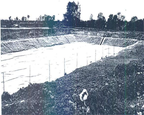
**Foto:** Otra vista general de la geo membrana en la laguna primaria, y del cerco perimétrico conformado con postes de madera y alambrado de púas N° 16 como indica el expediente técnico.
