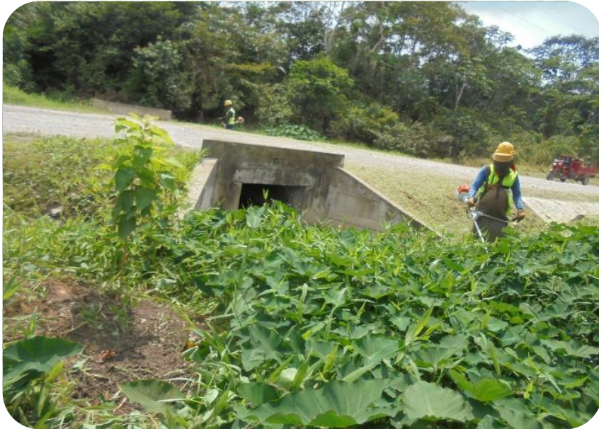
Actividad de Limpieza de Alcantarilla en ingreso y salida de flujos de agua por parte de la Micro Empresa asignada.
