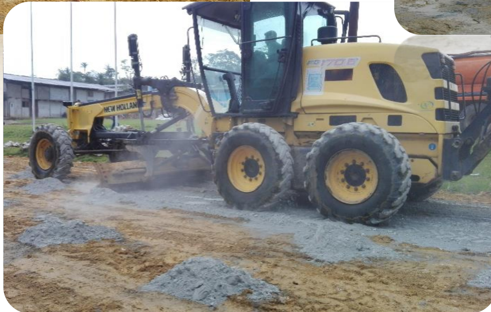
Vista 4: Se realiza el tendido del aditivo sólido (cemento)
