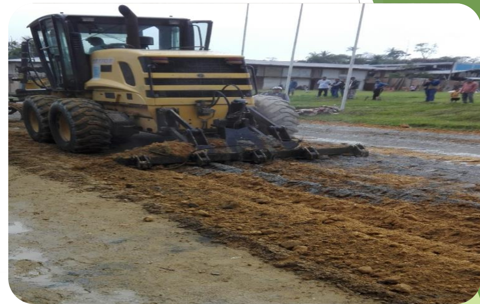
Vista 5: Se realiza el proceso de mezclado y batido del material sólido y el material granular
