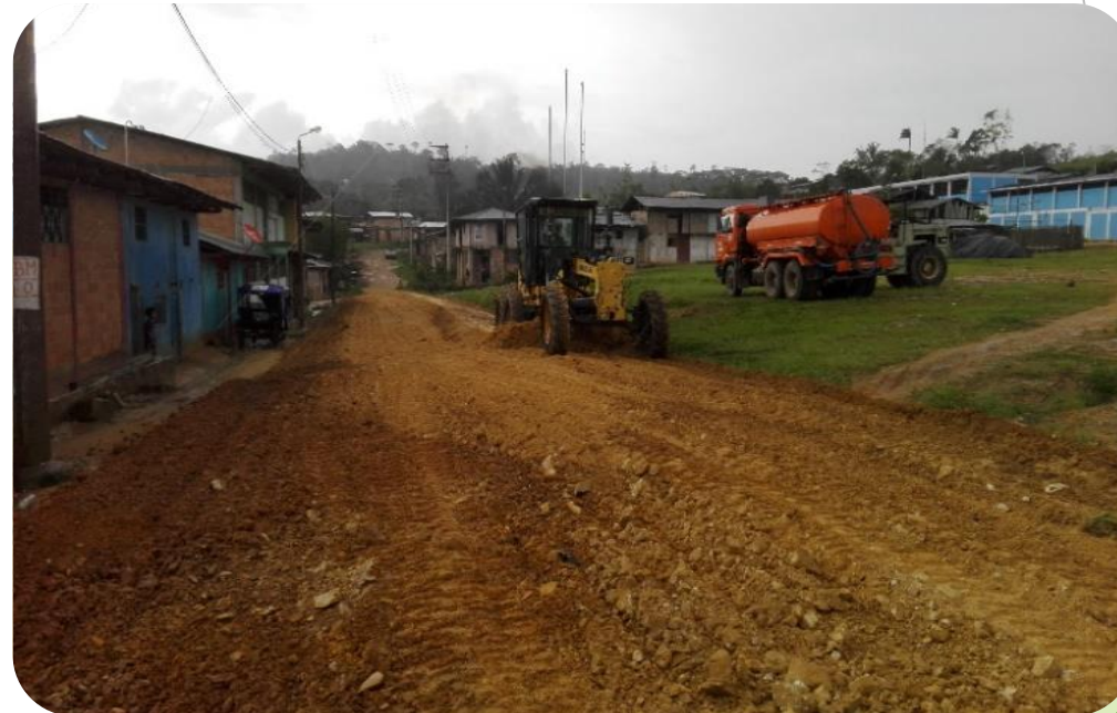
Vista 2: Escarificado y corte del afirmado granular existente
