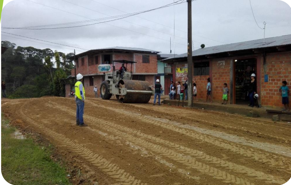
Vista 8: Se realiza la compactación después del perfilado de la superficie
