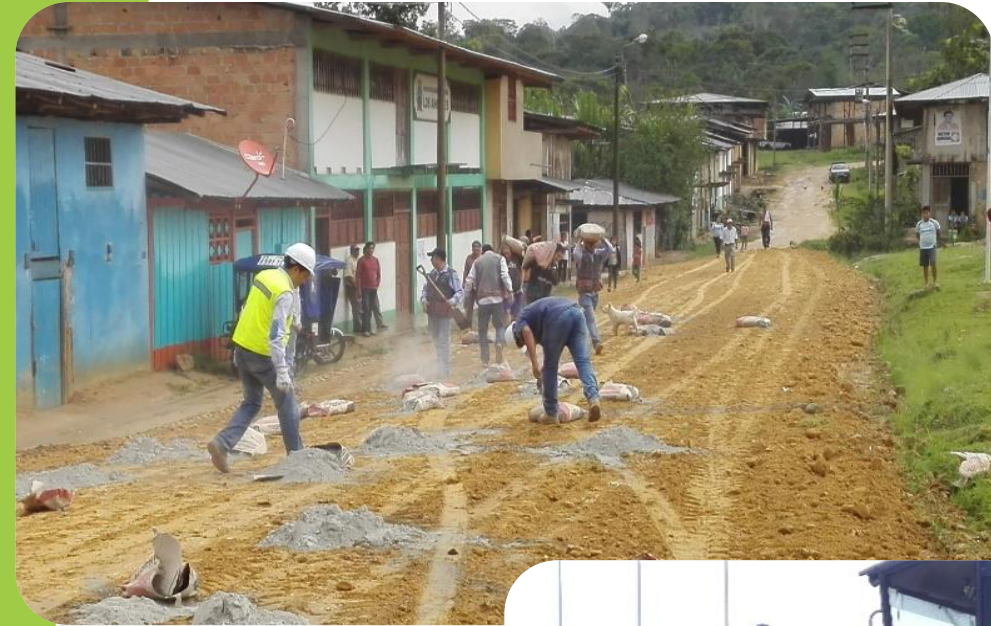
Vista 3: Se realiza la distribución e incorporación del aditivo sólido (cemento)
