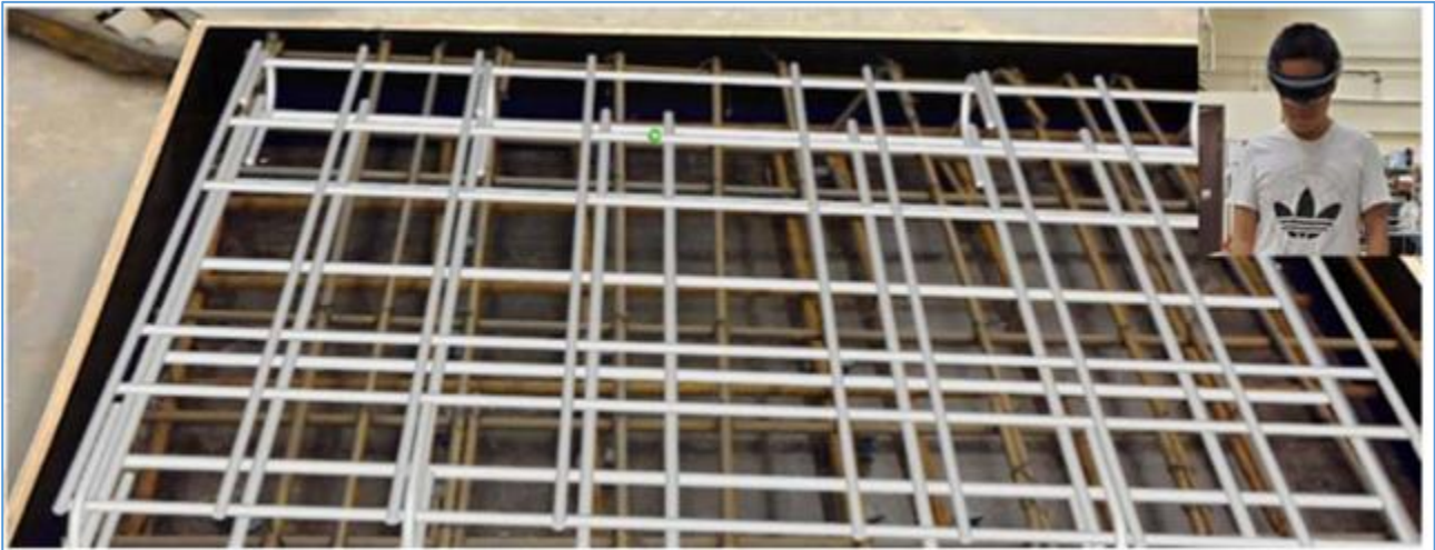
Figura 11. Inspección del refuerzo de elementos de concreto armado usando realidad aumentada
