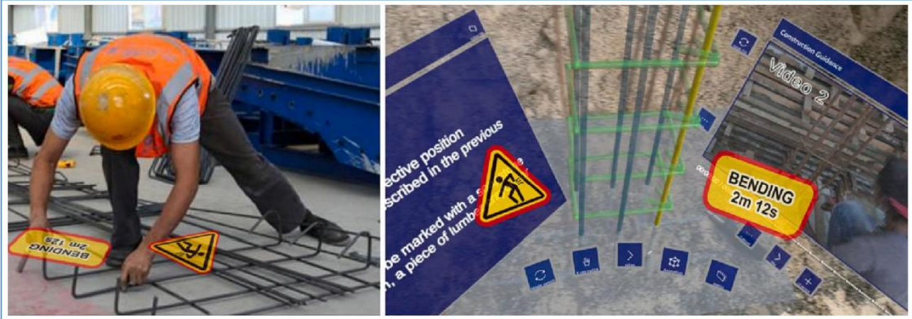
Figura 6. Empleo de realidad aumentada en el armado de acero de refuerzo
