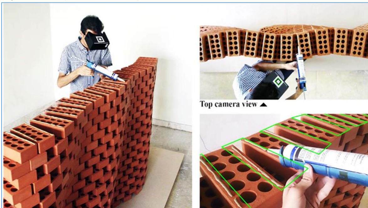
Figura 38. Alta precisión en trabajos de albañilería
