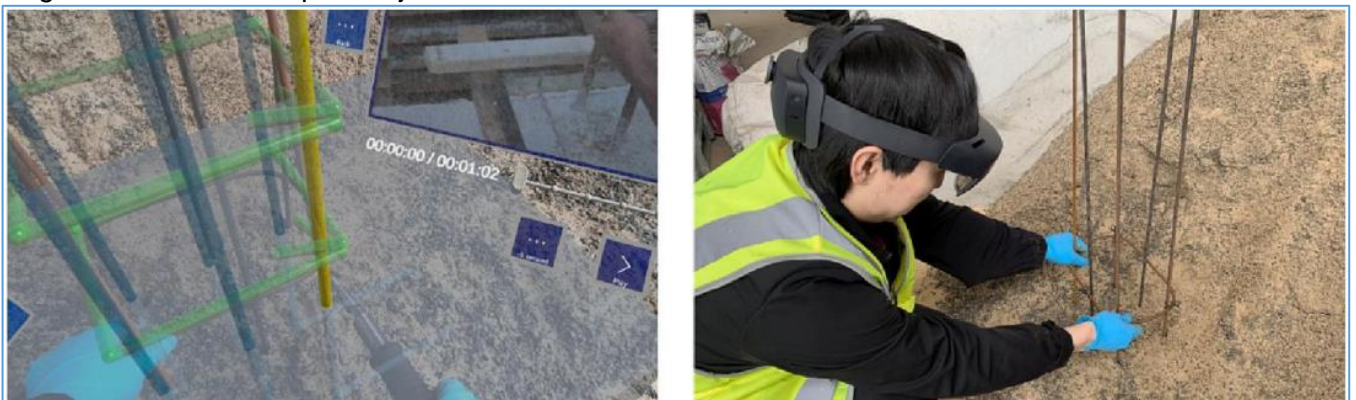
Figura 40. Menor tiempo en ejecutar armaduras de acero
