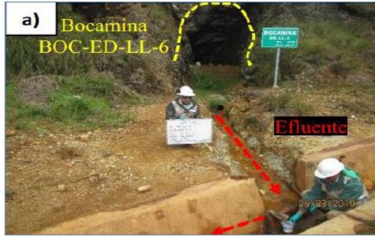
Esta acción desvirtúa el muestreo ambiental en este punto, dado que los resultados de muestreo se verían alterados por los elementos del suelo presentes en el canal de tierra.
