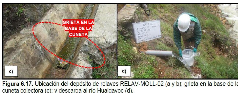
Figura 6.17. Ubicación del depósito de relaves RELAV-MOLL-02 (a y b); grieta en la base de la cuneta colectora (c); y descarga al río Hualgayoc (d).
