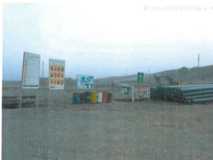
Foto N° 04: Vista del punto de acopio ubicado en el Depósito de Relaves Ocroyoc, donde se realizaron actividades de limpieza y eliminación de residuos acumulados.
