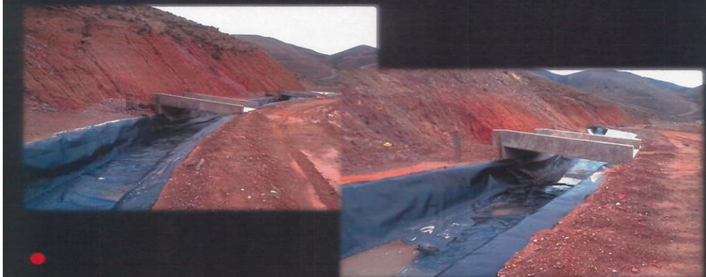
CAPTACIONES MENORES RECUBIERTAS TEMPORALMENTE CON GEOMEMBRANA
