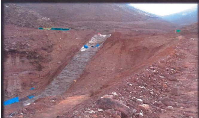
CAPTACIONES MENORES RECUBIERTAS TEMPORALMENTE CON GEOMEMBRANA
