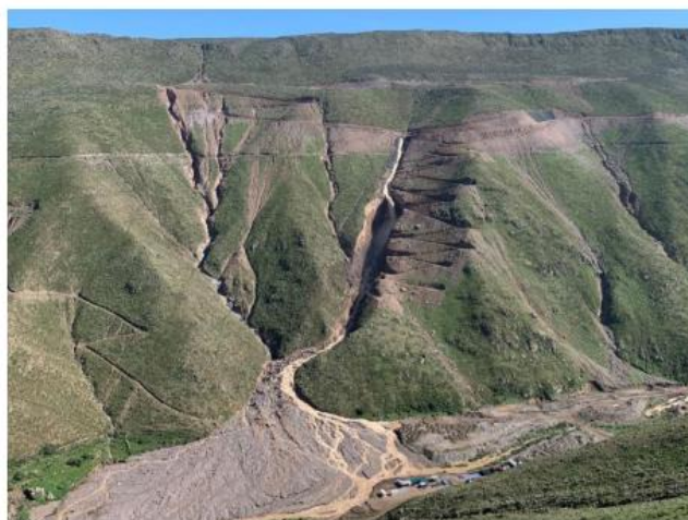
Imagen 12: Desembocadura del agua proveniente del Túnel Torata a su cauce natural.
