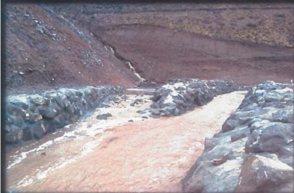
ENROCADO CAPTACIÓN MENOR 8 PROGRESIVA 1+600
