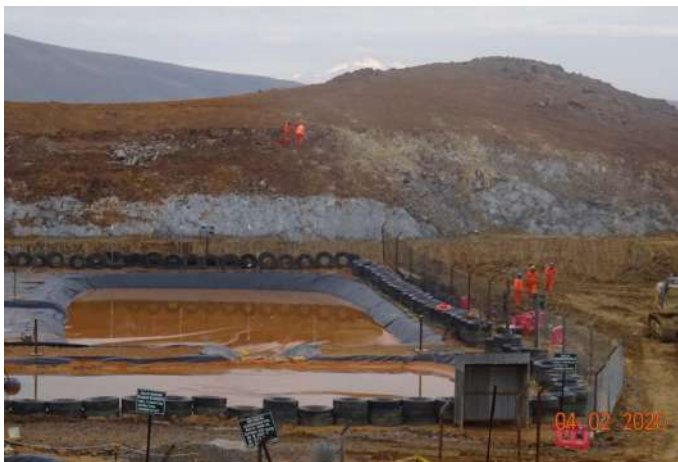
Fotografía 2: Vista del proceso de excavación del terreno para la construcción de la Poza de 5000 m3.
