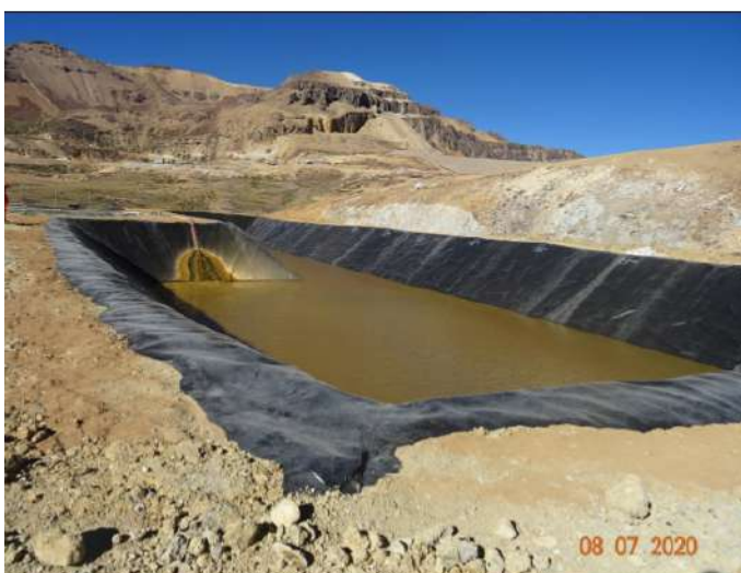
Fotografía 9: Vista de la Poza de 5000 m3 a la cual ingresan el agua tratada provenientes de los tanques de neutralización.
