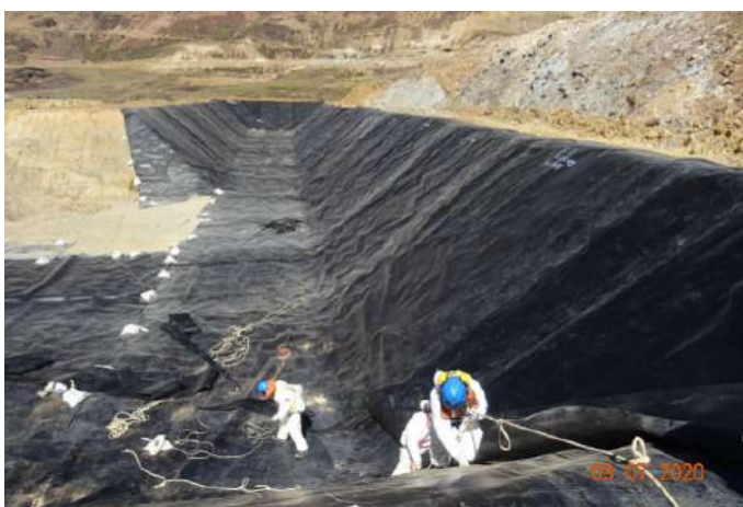
Fotografía 7: Vista del proceso de revestimiento de la Poza de 5000 m3 con material de geomembrana.
