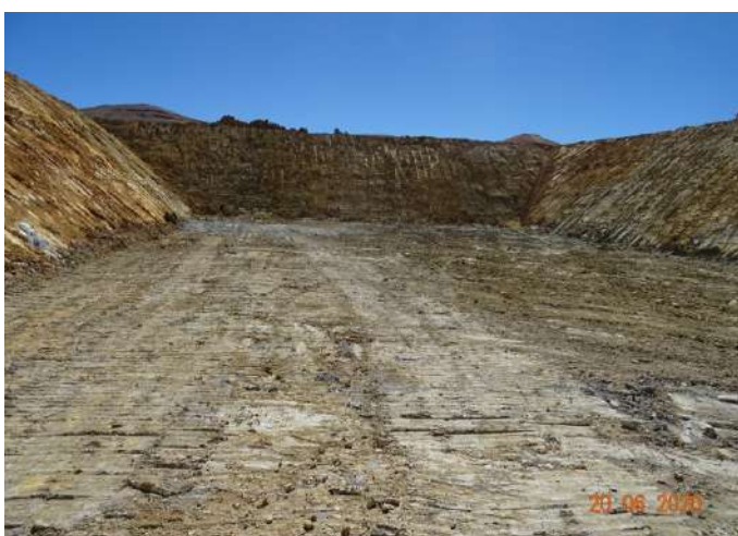
Fotografía 3: Vista del proceso de revestimiento de la Poza de 5000 m3 con material arcilloso.
