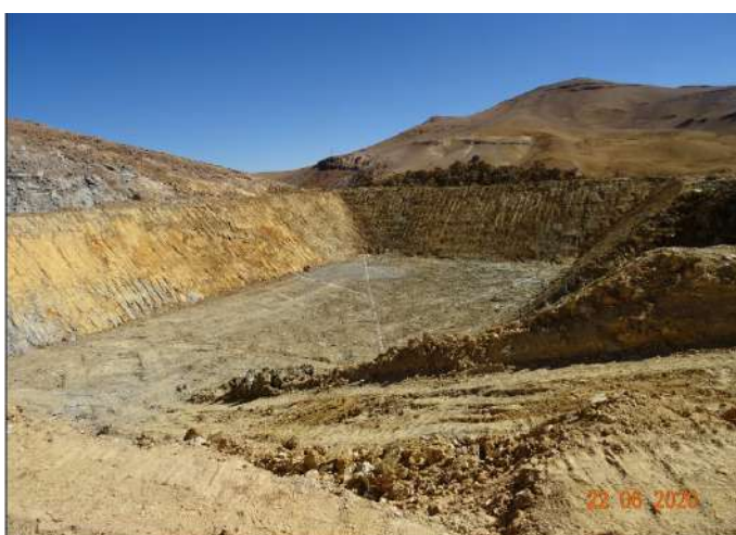
Fotografía 4: Vista del proceso de revestimiento de la Poza de 5000 m3 con material arcilloso.
