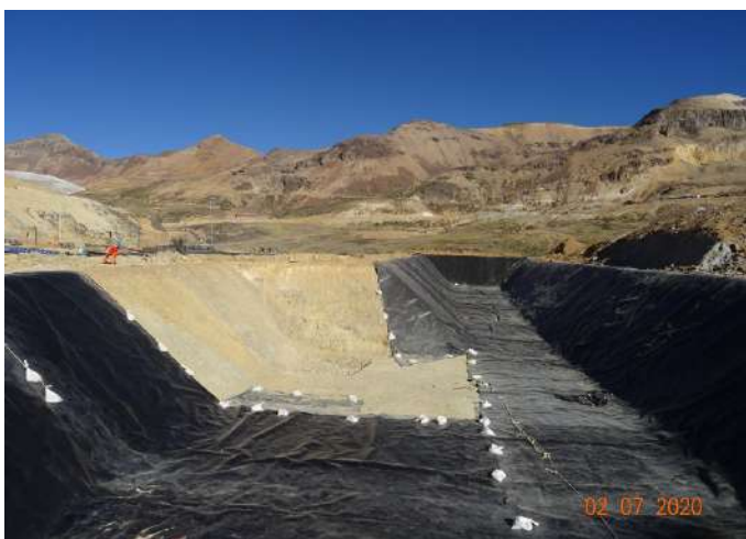
Fotografía 6: Vista del proceso de revestimiento de la Poza de 5000 m3 con material de geomembrana.
