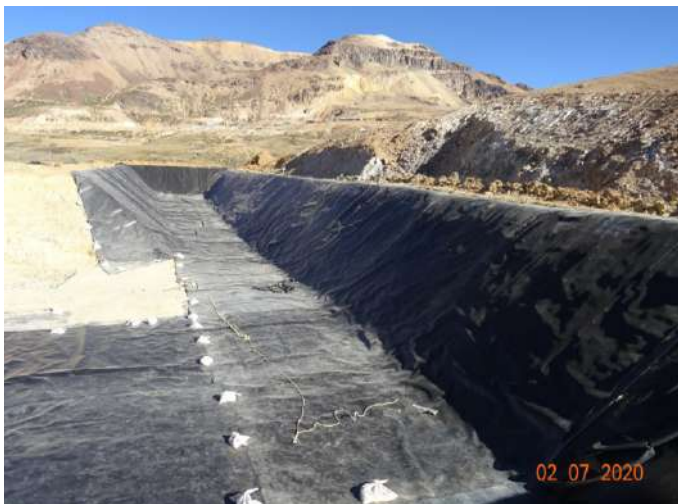
Fotografía 5: Vista del proceso de revestimiento de la Poza de 5000 m3 con material de geomembrana.
