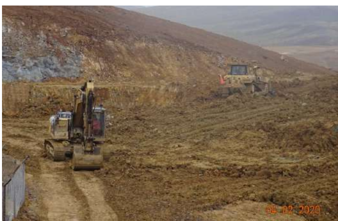
Fotografía 1: Vista del proceso de excavación del terreno para la construcción de la Poza de 5000 m 3 .
