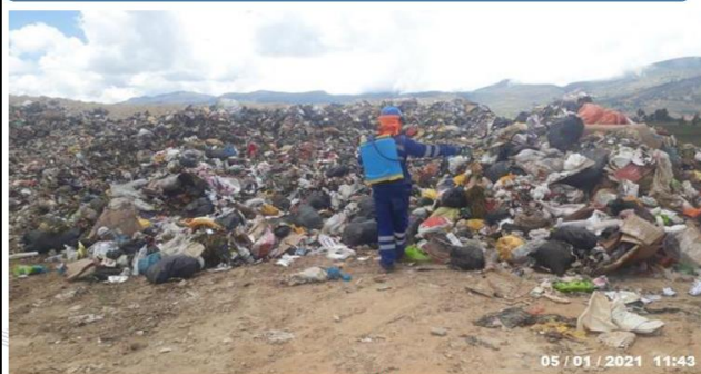
FOTO N°14.- DESINFECCIONES Y CONTROL DE VECTORES SANITARIO-APLICACION DE EM. EN CELDA DE DISPOSICION DE RESIDUOS SOLIDOS.
