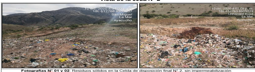
Fotografías N° 01 y 02: Residuos sólidos en la Celda de disposición final N° 2, sin impermeabilización
