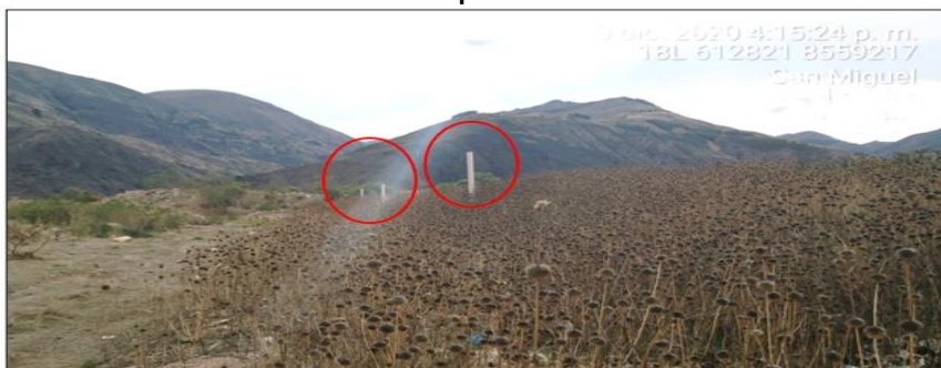
Vista de chimeneas sin quemadores en la celda N° 1
