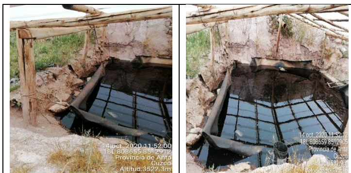
Fotografías N° 14 y 15 1 . - Se aprecia la geomembrana sujeta a las vigas de madera del techo de la poza de lixiviados.
