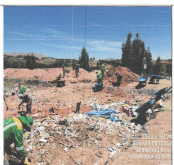
Fotografía N° 641.- Se observa labores de esparcido de residuos sólidos y cobertura de los mismos en la celda de disposición final de residuos sólidos ubicada en las coordenadas UTM Zona 18L (WGS-84) 808704 E, 8512864 N.
