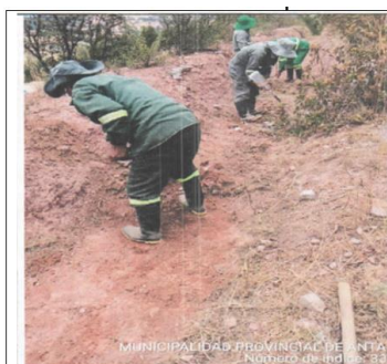
Fotografía N° 10 51 . - Se observa la limpieza de los canales perimetrales de escorrentía en la Trinchera II.
