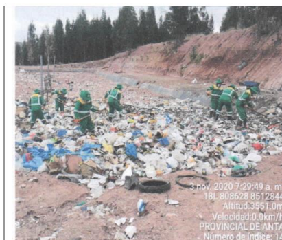
Fotografía N° 742.- Se observa labores de esparcido de residuos sólidos en la celda de disposición final ubicada en las coordenadas UTM Zona 18L (WGS-84) 808628 E, 8512844 N.
