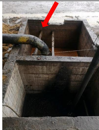
**Fotografía IMG\_012.** Vista de la poza de concreto provista de tres (3) divisiones ( trampa de grasa) a donde los efluentes producto de la clarificación son conducidos a través de una tubería metálica, para la remoción de grasas.
