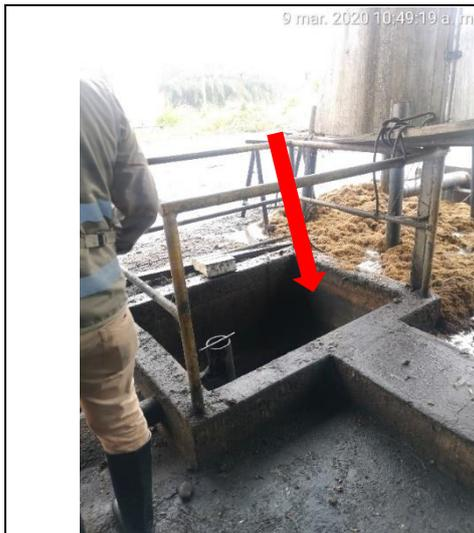
**Fotografía IMG\_007.** Vista de la poza ciega de concreto de 3m<sup>3</sup> de empleada para almacenar los efluentes generados durante el proceso de esterilización de la fruta.
