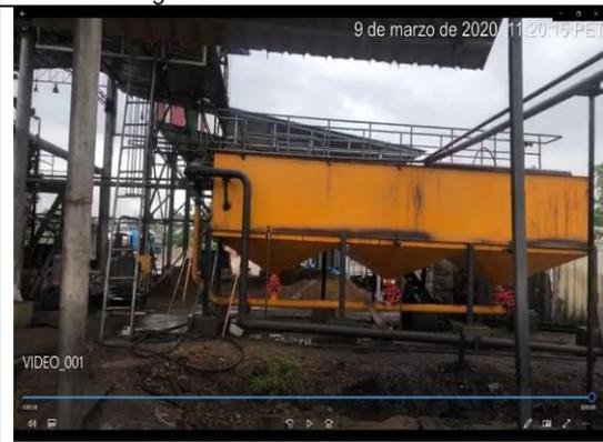
**Captura minuto 00:38 del Video\_001.** Vista del tanque florentino de capacidad de 15m<sup>2</sup>, desde el cual los efluentes son evacuados hacia un canal de suelo sin recubrimiento.
