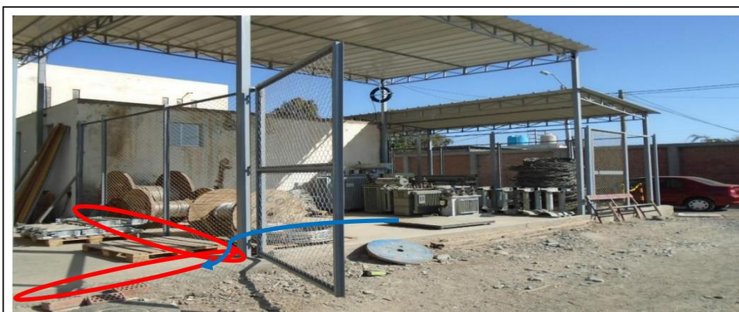
**Nota:** Vista general del “Almacén de materiales nuevos (Almacén 2) – Almacén Nazca”. En rojo se indica parte del perímetro que no cuenta con muro de contención. Flecha azul indica posible camino del flujo de aceite dieléctrico en caso de derrame. Tomado del panel fotográfico anexo al Acta de Supervisión.
