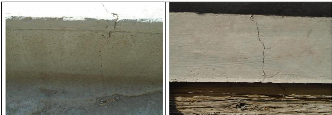
**Nota:** Vista cercanas del muro frontal del “Almacén de materiales nuevos (Almacén 2) – Almacén Nazca”. Se aprecia mal estado de este muro, toda vez que tiene grietas. Tomado del panel fotográfico anexo al Acta de Supervisión
