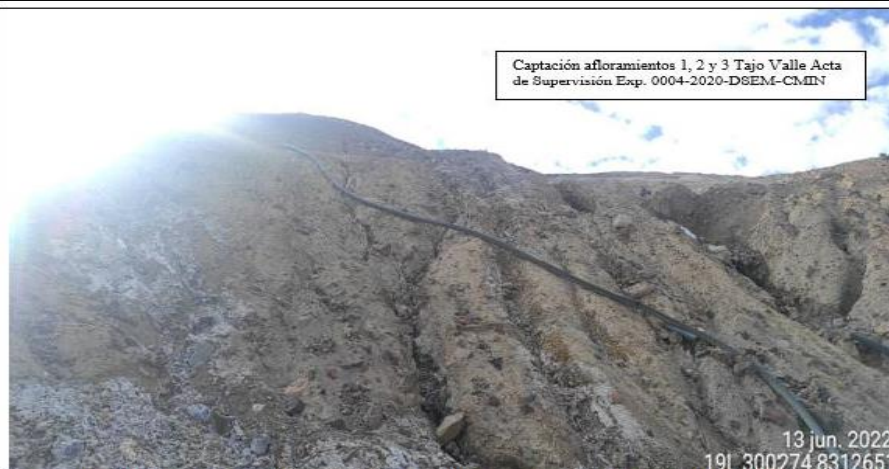
Fotografía 12: Tubería de conducción de los afloramientos N° 1, 2 y 3 hacia la PTAA DD N° 1, la cual ha sido supervisada por el OEFA en supervisiones en UM Arasi en los años 2020, 2021 y 2022.
