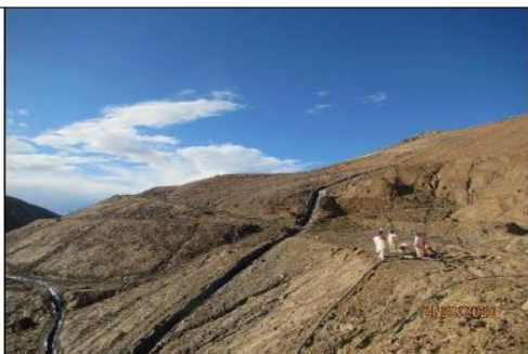
Fotografía 10: Implementación de la tubería de salida de la poza de sedimentación para conducción de los afloramientos N° 2 y N° 3 hacia la PTAA DD N° 1. Fuente: Supervisión 26.02.22-15.03.22
