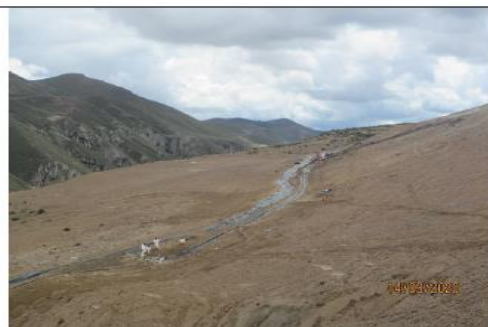
Fotografía 9: Implementación del sistema de captación de los afloramientos N° 2 y 3. Fuente: Supervisión 26.02.22-15.03.22
