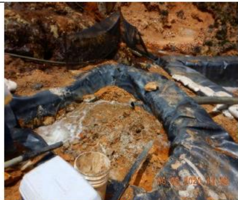
Fotografía 3: Descolmatación de la poza de sedimentación. Fuente: Anexo 8 – Acta de Supervisión 26.02.20-15.03.20
