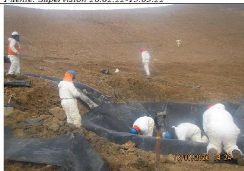
Fotografía 7: Construcción de la poza de sedimentación del sistema de captación de los afloramientos N° 2 y 3. Fuente: Supervisión 26.02.22-15.03.22
