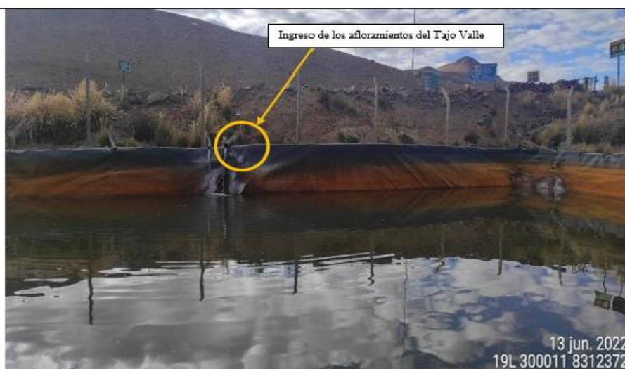
Fotografía 14: Ingreso del flujo de agua (afloramientos N° 1, 2 y 3) a la poza de homogenización de la PTAA DD N° 1, lo cual ha sido supervisada por el OEFA en supervisiones en UM Arasi en los años 2020, 2021 y 2022.
