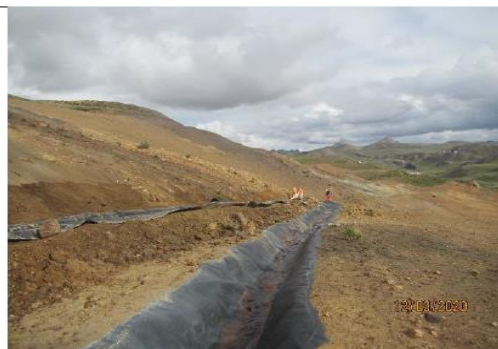
Fotografía 5: Trabajos de captación de los afloramientos N° 2 y 3 mediante un canal hacia una piza y de esta conducido a por una tubería a la PTAA DD N° 1. Fuente: Supervisión 26.02.22-15.03.22
