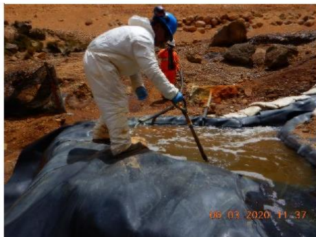
Fotografía 153. IMG_6455: Vista del inicio de la limpieza a la poza sedimentadora, con palas para retirar el exceso de sedimentos con la que contaba la poza.
