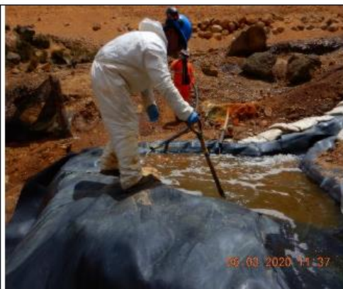
Fotografía 2: Acción inmediata por parte del operador descolmataando la poza Fuente: Anexo 8 – Acta de Supervisión 26.02.20-15.03.20
