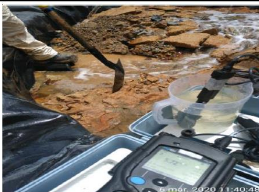
Fotografía 155. TimePhoto_20200306_114048: Vista de la limpieza de la poza sedimentadora, logrando recuperar el curso posterior a la poza de colección.
