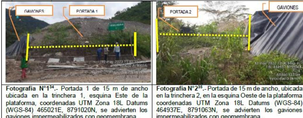
Fotografía N°1<sup>34</sup>.- Portada 1 de 15 m de ancho ubicada en la trinchera 1, esquina Este de la plataforma, coordenadas UTM Zona 18L Datums (WGS-84) 465021E, 8791020N, se advierten los gaviones impermeabilizados con geomembrana.
