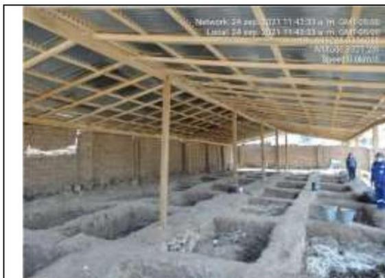
**Fotografía 7<sup>68</sup>.** Se observa la Planta de compostaje con techo y la habilitación de pozas sobre el suelo natural para la valorización de residuos sólidos orgánicos.
