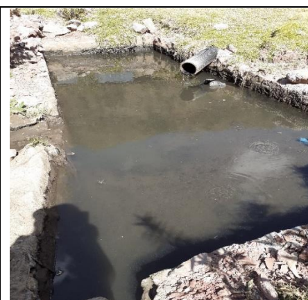
Fotografía con código 20190626_130452 se visualiza la poza de sedimentación, donde se observa acumulación de efluentes.
