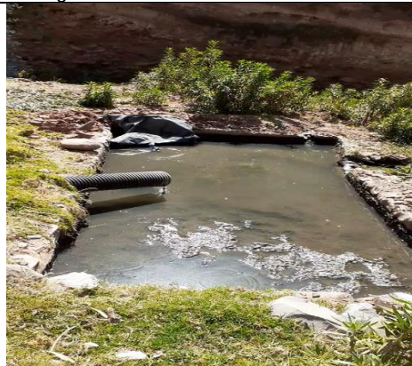
Video con código 20190626_125935 captura de imagen al 02:14, se observa la poza de sedimentación a donde son conducidos los efluentes para posteriormente ser conducidos a través de un canal de terreno afirmado.
