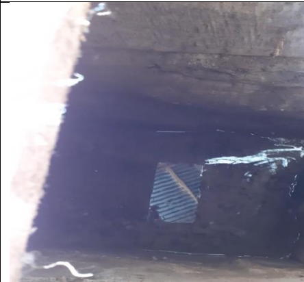
Video con código 20190626_125935 captura de imagen al 01:44, se observa la descarga del agua residual proveniente del área de lavado , donde una vez puesta en marcha, también será conducido el efluente del área de teñido .
