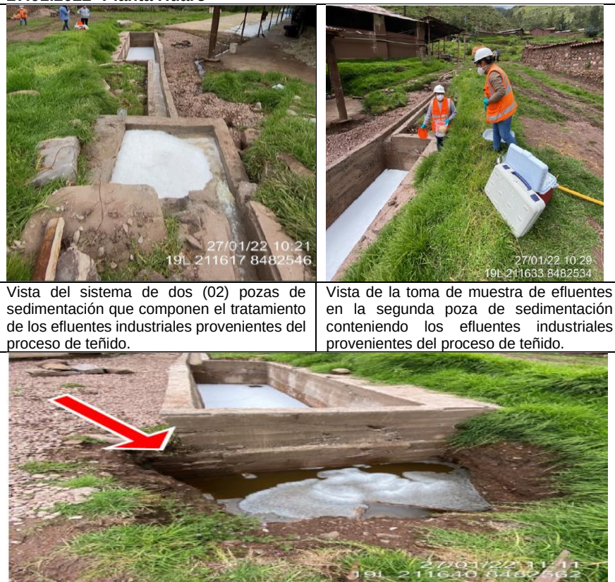
Cuadro N° 3: Panel fotográfico de las acciones de verificación del 27.01.2022- Planta Huaro
