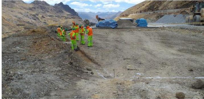
Fotografía N° 01: Habilitación de terreno y excavación de caja de canal; coordenadas UTM WGS84 (520959E; 8569154N).
