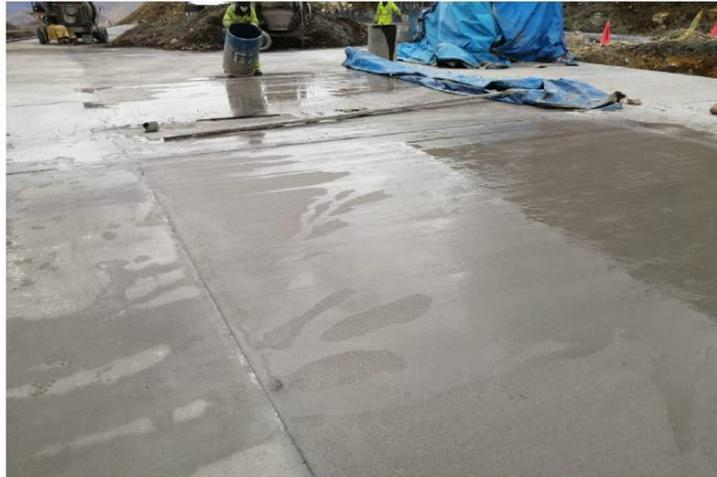
Fotografía N° 07: Losa de concreto con superficie frotachado; coordenadas UTM WGS84 (520959E; 8569154N).
