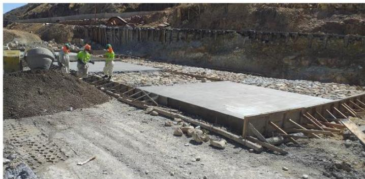
Fotografía N° 05: Procedimiento de construcción empleado por paños y juntas de construcción; coordenadas UTM WGS84 (520959E; 8569154N).
