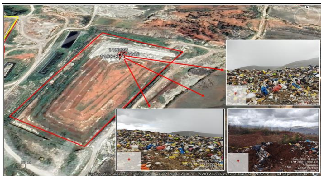
Imagen N° 5 Residuos sin cobertura sobre la infraestructura de disposición final N° 2
