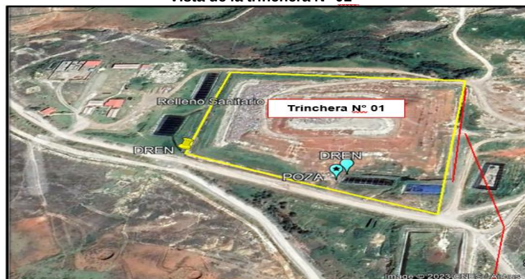
Vista de la trinchera N° 01
