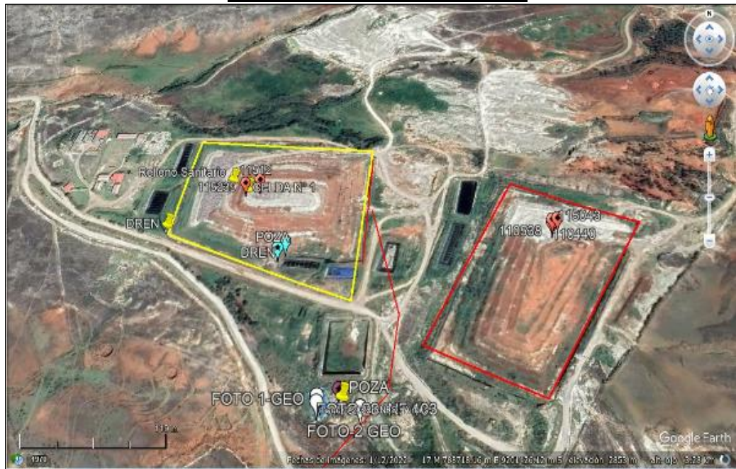
Imagen N° 4 Vista de la infraestructura N° 1 y N° 2
