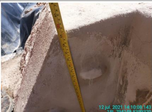
Fotografía N° 30: Vista de la medición de la sección de la caja colectora N° 3, en el cual se puede observar que la altura cuenta con la extensión establecida en el instrumento de gestión ambiental.
