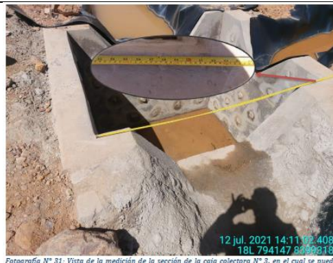
Fotografía N° 31: Vista de la medición de la sección de la caja colectora N° 3, en el cual se puede observar que las medidas de dicha infraestructura hidráulica cumple con la extensión establecida en el instrumento de gestión ambiental.
