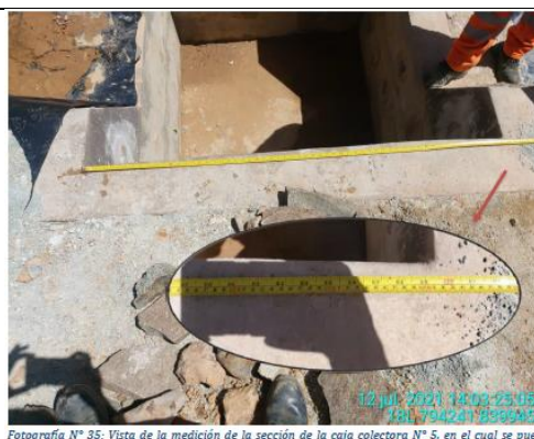
Fotografía N° 35: Vista de la medición de la sección de la caja colectora N° 5, en el cual se puede observar que las medidas de dicha infraestructura hidráulica cumple con la extensión establecida en el instrumento de gestión ambiental.
