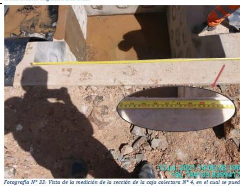
Fotografía N° 33: Vista de la medición de la sección de la caja colectora N° 4, en el cual se puede observar que las medidas de dicha infraestructura hidráulica cumple con la extensión establecida en el instrumento de gestión ambiental.
