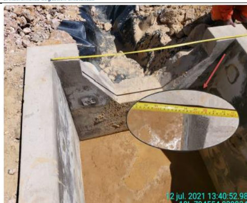
Fotografía N° 37: Vista de la medición de la sección de la caja colectora N° 6, en el cual se puede observar que las medidas de dicha infraestructura hidráulica cumple con la extensión establecida en el instrumento de gestión ambiental.
