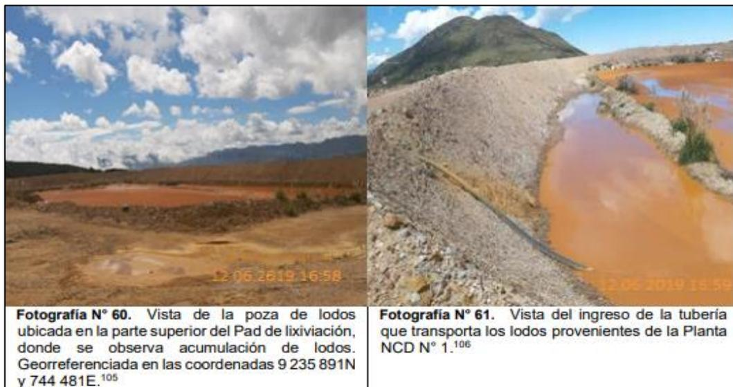
**Fotografía N° 60.** Vista de la poza de lodos ubicada en la parte superior del Pad de lixiviación, donde se observa acumulación de lodos. Georreferenciada en las coordenadas 9 235 891N y 744 481E.<sup>105</sup>
