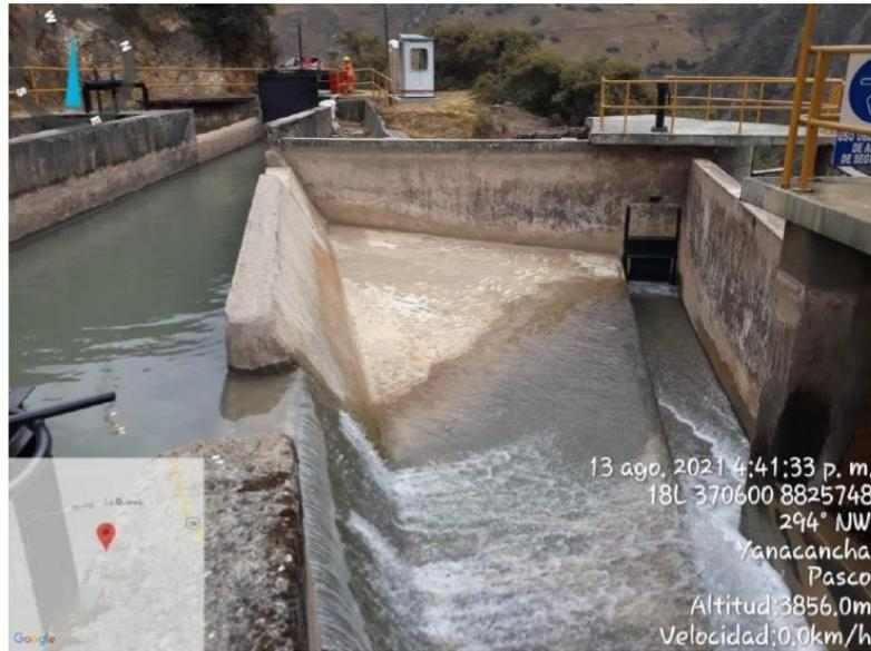
**Imagen No. 9:** Salida por rebose en la "Tasa" de la Central Hidroeléctrica Candelaria
