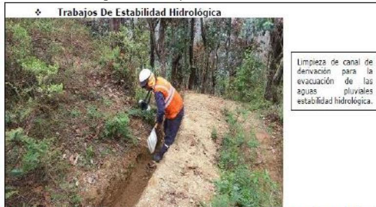
Figura N° 47. Actividades de Cierre Progresivo – Estabilidad Hidrológica comunicado en el Informe del Plan de Cierre de Minas Segundo Semestre 2018.
