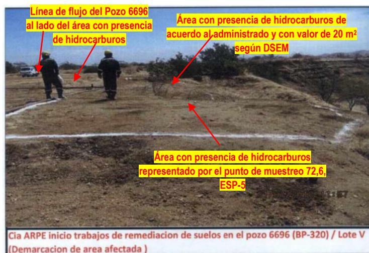
presencia de hidrocarburos en el componente suelo, está relacionado a la línea de flujo del Pozo 6696, en específico a la falla de la integridad de dicha línea de flujo.
