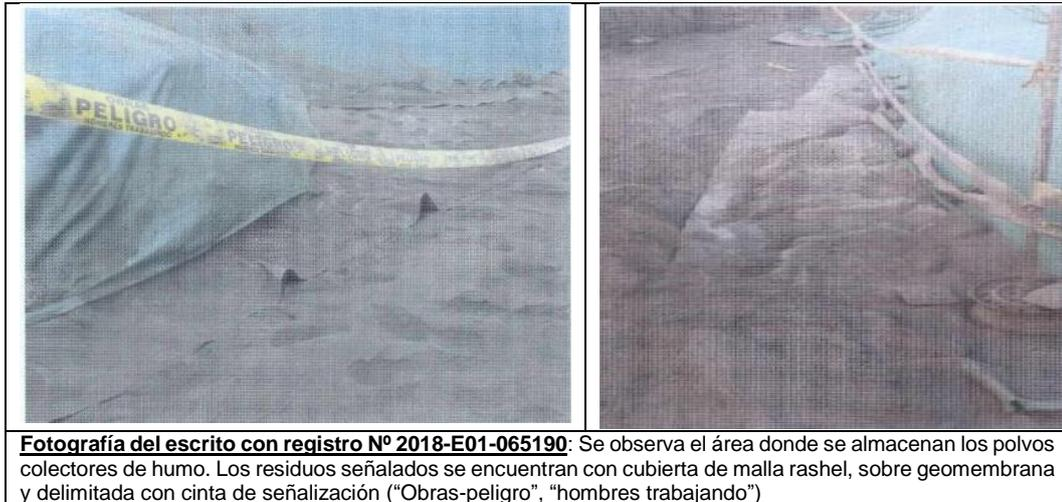
**Fotografía del escrito con registro N° 2018-E01-065190:** Se observa el área donde se almacenan los polvos colectores de humo. Los residuos señalados se encuentran con cubierta de malla rassel, sobre geomembrana y delimitada con cinta de señalización ("Obras-peligro", "hombres trabajando")
