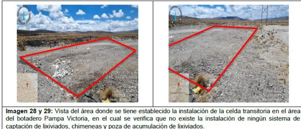
**Imagen 28 y 29:** Vista del área donde se tiene establecido la instalación de la celda transitoria en el área del botadero Pampa Victoria, en el cual se verifica que no existe la instalación de ningún sistema de captación de lixiviados, chimeneas y poza de acumulación de lixiviados.
