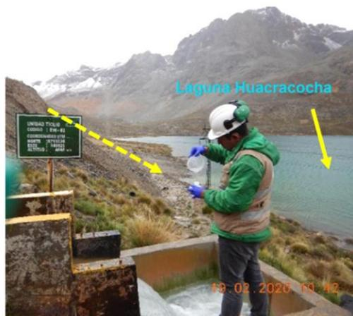
**Fotografía N° 32:** Vista de la toma de muestra del efluente denominado ESP-1 (EH-02), se aprecia que se ha realizado en el canal de concreto antes de su descarga en la tubería de HDPE de 24 pulgadas hacia la laguna Huacracocho.
