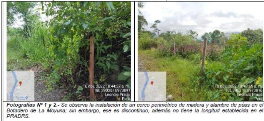
*Fotografías N° 1 y 2.- Se observa la instalación de un cerco perimétrico de madera y alambre de púas en el Botadero de La Moyuna; sin embargo, ese es discontinuo, además no tiene la longitud establecida en el PRADRS.*
