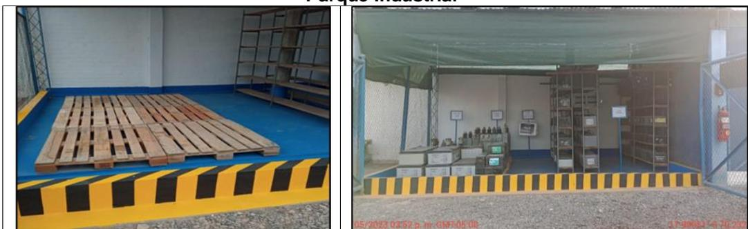
Nota. Se observa la impermeabilización del piso y la terminación de la berma de contención en todo el perímetro del almacén de residuos sólidos peligrosos de la SET Parque Industrial. Adaptado del registro fotográfico presentado por el administrado en el escrito con Registro N° 2023-E01-542317.
