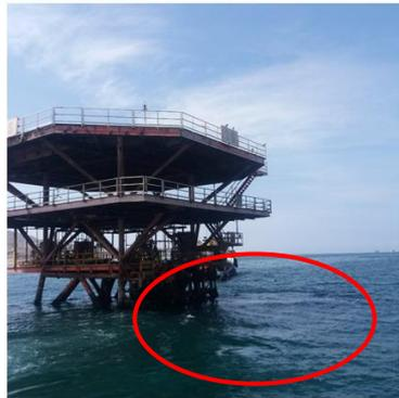
Después de bloquear las válvulas en ambas puntas de línea 3 1/2" circuito gas lift PN5-SS en las dos plataformas, no se observa fuga de gas entre plataformas
