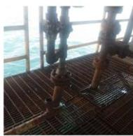
Plataforma SS, Línea 3 1/2" circuito gas lift PN5-SS fuera servicio con válvulas cerradas
