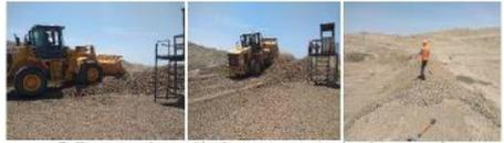
Relleno y conformación de muro con maquinaria y manual.
