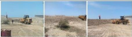
Relleno y conformación de muro con maquinaria.
