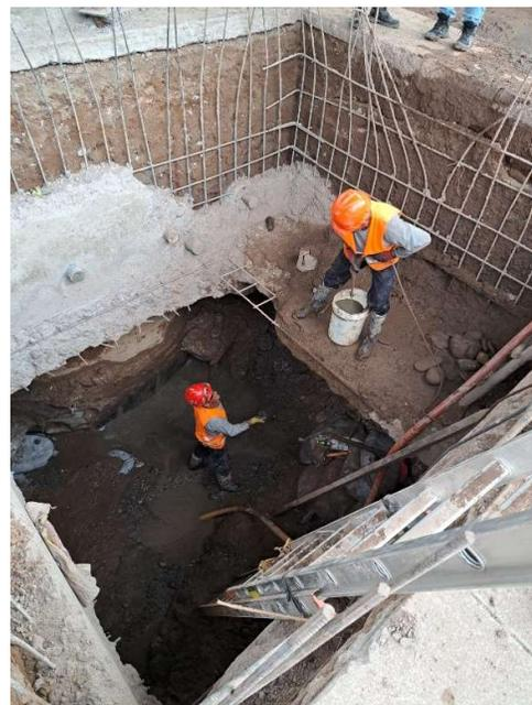
4. Vaciado de solado de concreto FC=100 KG/CM2, E=4" en la cámara seca de la Estación de Bombeo.
