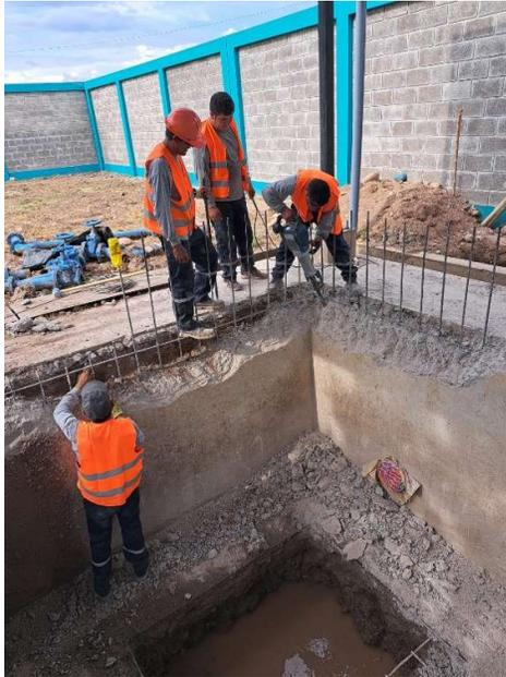
1. Demolición de la estructura de concreto en la cámara seca.
