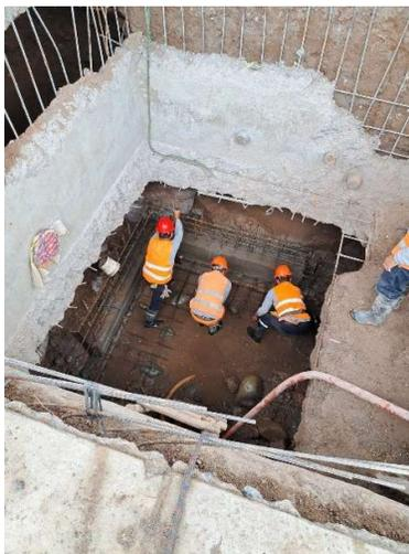
3. Desencofrado de muros de concreto en la cámara seca de la Estación de Bombeo.
