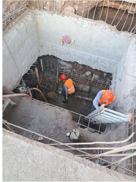
2. Vaceo de muros de concreto FC=210 KG/CM2, E=4" en la cámara seca de la Estación de Bombeo.
