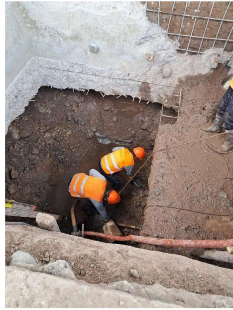
2. Excavación manual en la cámara seca de la Estación de Bombeo.
