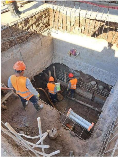
1. Encofrado de muros en la cámara seca de la Estación de Bombeo.
