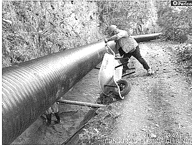
Colocación de cama de arena en el canal principal tubería. 900mm
