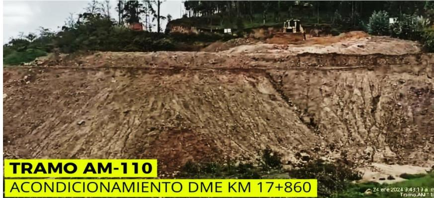
FOTO N° 11: En fecha 24/01/2024, se realizó el acondicionamiento de DME KM 17+860 AM-110.
