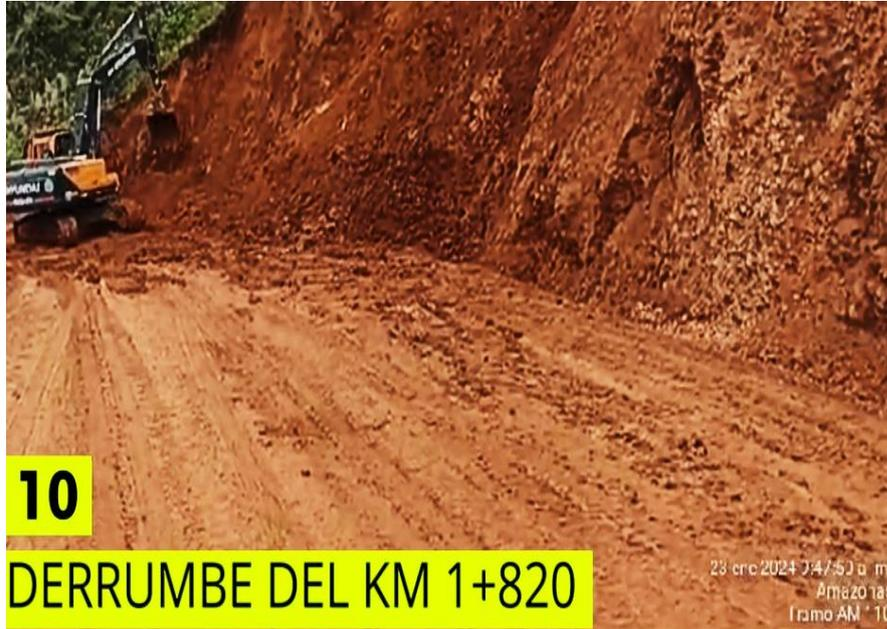
FOTO N° 09 En fecha 23/01/2024, se realizó la remoción de derrumbes del km 01+820 AM-110.
