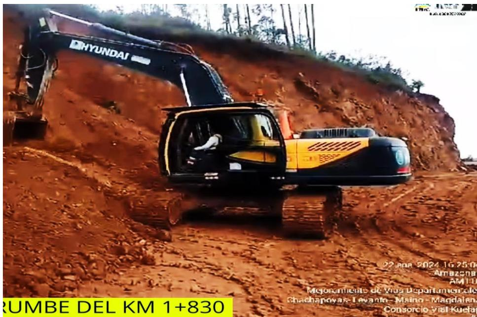
FOTO N° 05: EL 22/01/2024, se realizó la remoción de derrumbes del km 01+830 AM-110.
