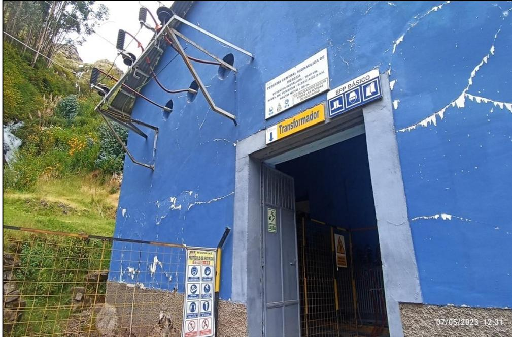
**Nota:** Fotografía recabada durante la supervisión posterior de mayo de 2023. Se aprecia la interconexión de 22.9 kV, no existiendo la subestación ni interconexión de 138 kV, como fue planteado en el EIA.
