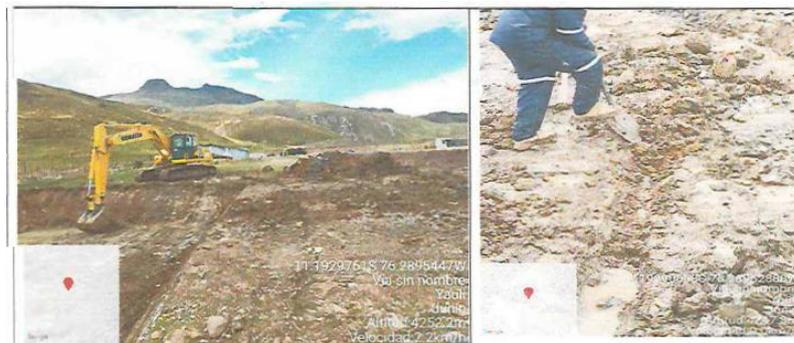
IMAGEN 12 y 13.- Se realizó la compactación del área de celda y la apertura de drenes.
