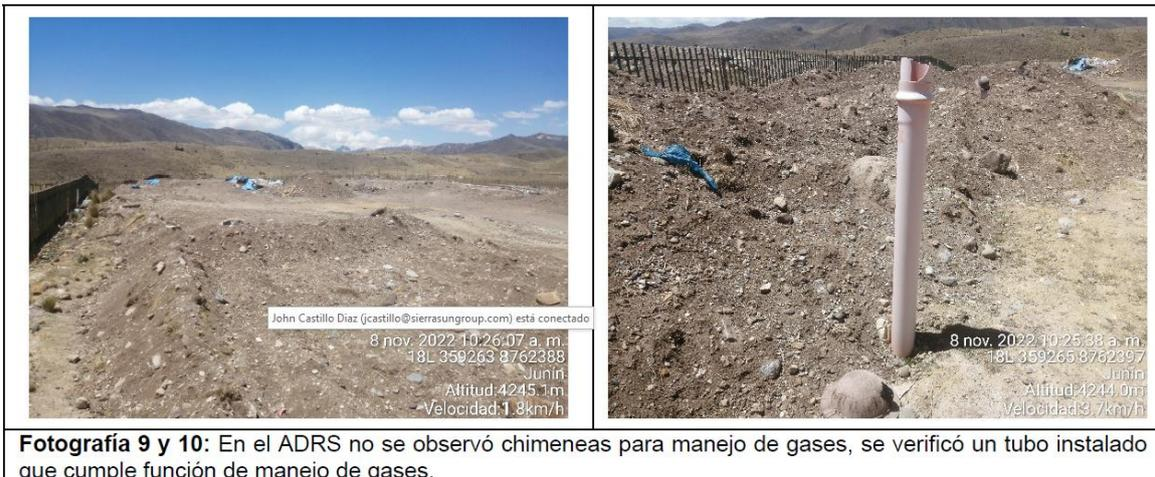
**Fotografía 9 y 10:** En el ADRS no se observó chimeneas para manejo de gases, se verificó un tubo instalado que cumple función de manejo de gases.
