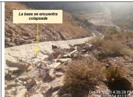
FOTOGRAFIA N° 31.- Vista desde un punto medio de la rápida de derivación donde se observa que su revestimiento de mampostería de piedra se encuentra colapsado (base, paredes y pantallas dissipadoras) y no fue retirado ni reconstruido (coordenada UTM WGS 84 19K N: 8 113 289 y E: 312 854).
