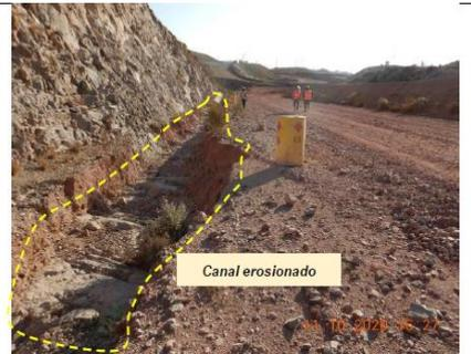
FOTOGRAFIA N° 33.- Vista del tramo 2 del canal de derivación, coordenada UTM WGS 84 19K N: 8 113 346 y E: 312 952, donde se observa que el canal que no tiene revestimiento no conforma una sección trapezoidal ya que su pared se encuentra erosionada.
