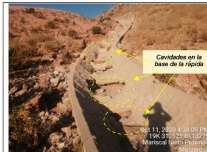
FOTOGRAFIA N° 30.- Vista de la rápida (canal de mampostería) de derivación desde su cota más baja o punto de entrega a la quebrada natural (la coordenada UTM WGS 84 19K N: 8 113 279 y E: 312 821), donde presenta cavidades que abarcan todo el ancho de la base de la rápida y dejan el suelo expuesto en los puntos donde se habrían colocado las pantallas dissipadoras que se habrían desprendido de la base de la rápida.
