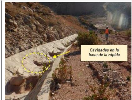
FOTOGRAFIA N° 32.- Vista desde la parte alta de la rápida de derivación (coordenada UTM WGS 84 19K N: 8 113 303 y E: 312 903) donde se observa sedimentos y piedras acumuladas en la rápida (canal de mampostería), además de cavidades en la base de la rápida donde las pantallas dissipadoras se habrían desprendido, dejando el suelo expuesto.
