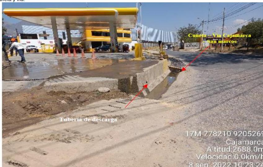
Fotografía 02: Vista de la cuneta, vía Cajamarca – San marcos y las tuberías que salen en dirección de la trampa de grasas.
