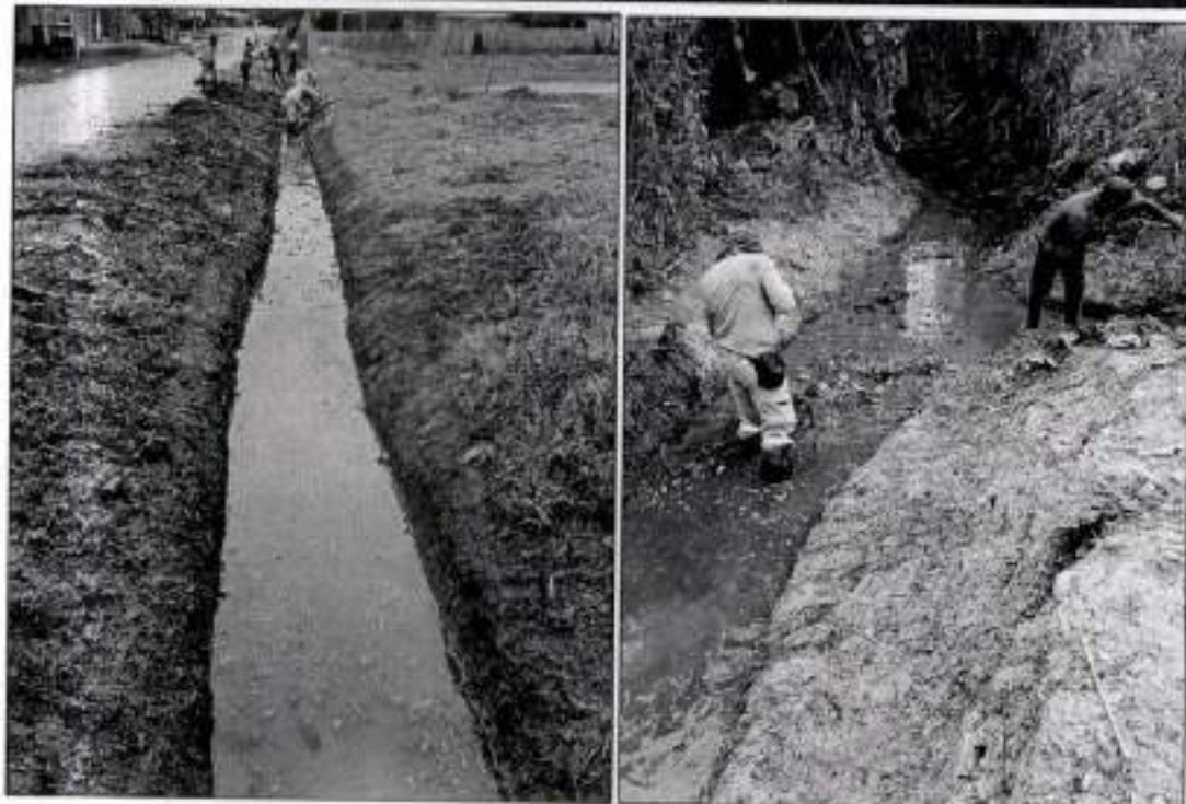
IMAGEN N08: Perfilación de los laterales del caño natural y además de la profundidad para evitar rebasamiento del agua.
