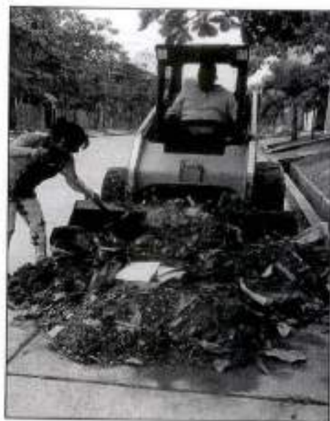
Imagen N°12: Recojo de residuos provenientes de la limpieza de zanjas pluviales, con el apoyo de un minicargador.
