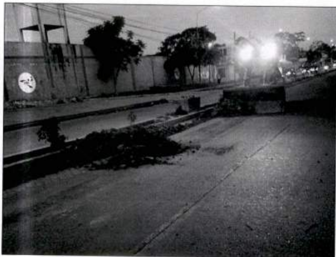
IMAGEN N04: Recojo de residuos generados en la limpieza de cunetas con apoyo de un minicargador.
