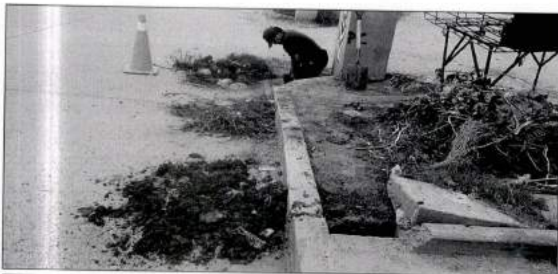
IMAGEN N02: La tierra extraída de las zanjas son acumuladas temporalmente al costado de la cuneta, en la vía.
