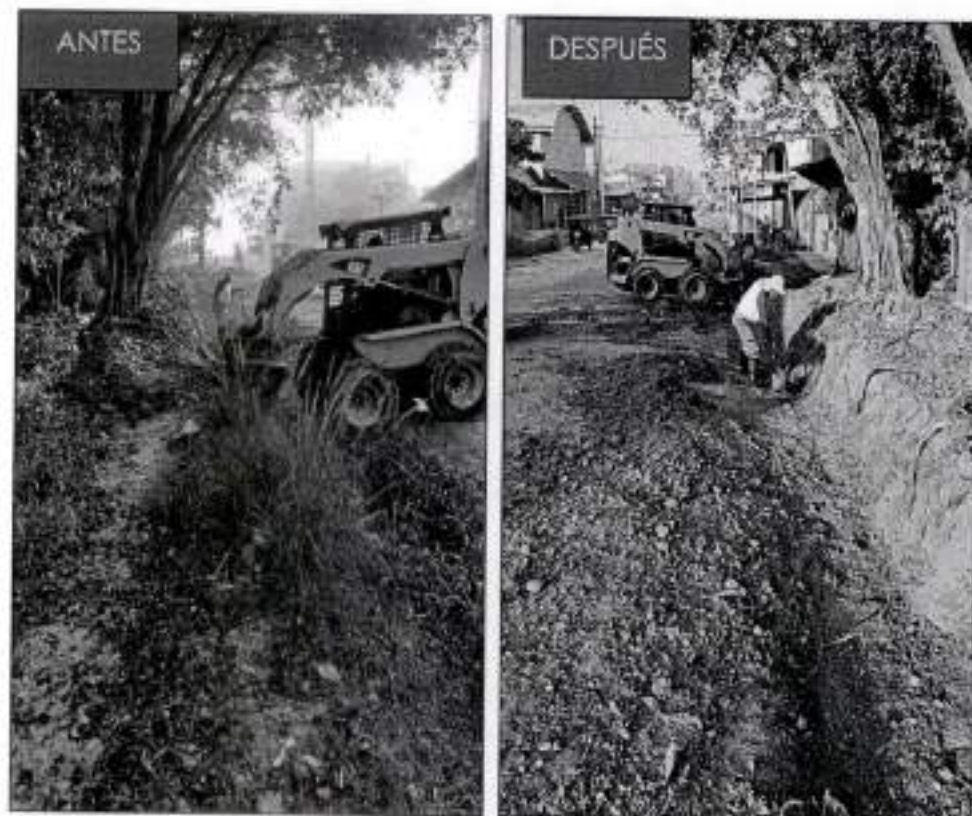
IMAGEN N° 08: Caso de Reapertura de zanja pluvial, con apoyo de un minicargador y el apoyo de un trabajador para evitar cortes de tuberías.
