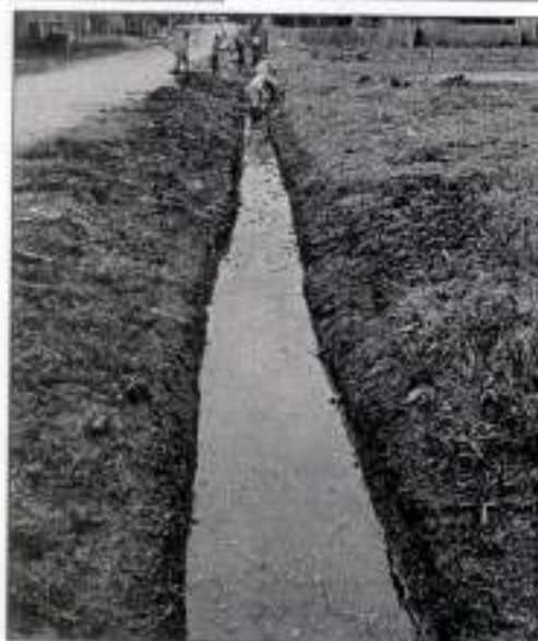
Imagen N° 11: Perfilado de zanjas pluviales y/o caños naturales, esto permite la mejor conducción del agua, evitando que el agua rebalse.
