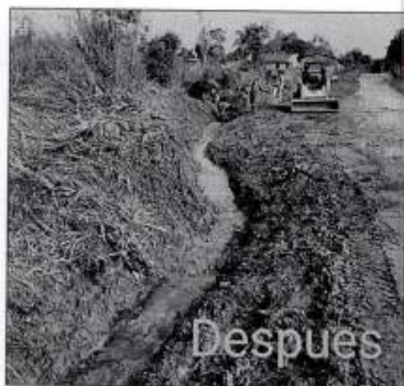
Imagen N° 10: Perfilado de zanjas con palas mediante excavación con palas los bordes y profundidad.
