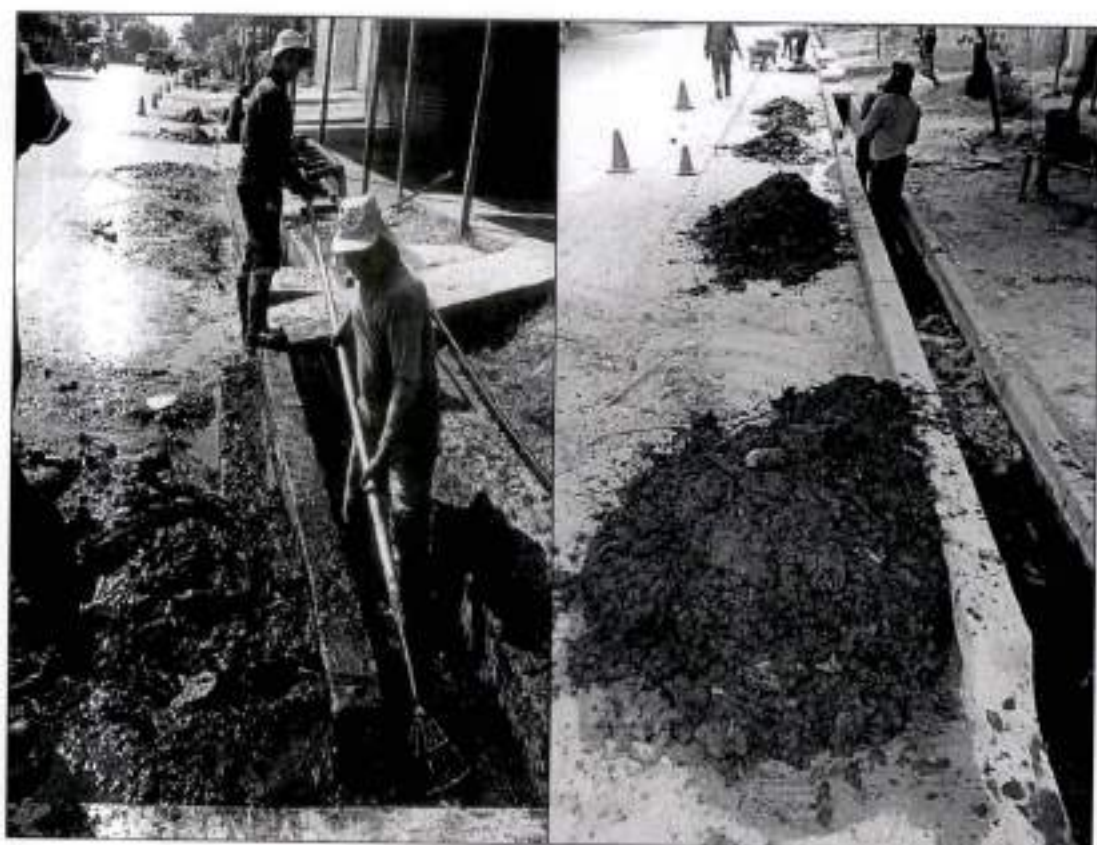
IMAGEN N01: Como primer paso se procede a retirar residuos y tierra que se encuentre dentro de la zanja pluvial/cuneta
