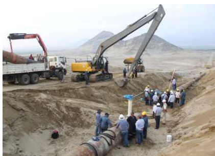
Ing. Manuel Llampén, Gerente General Regional y Ing. Edilberto Ñique, Gerente del PECH, supervisan obras de reparación.
