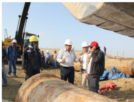
Ing. Manuel Llampén, Gerente General Regional e Ing. Edilberto Ñique, Gerente del PECH, supervisan obras de reparación.
