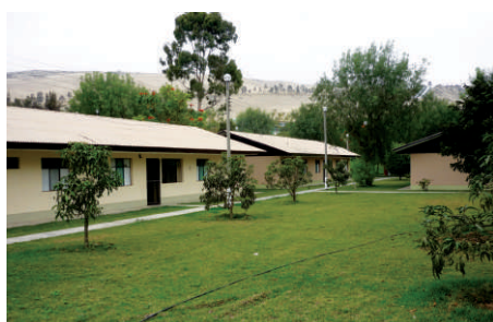
Instalaciones de campamento San José, valle Virú
